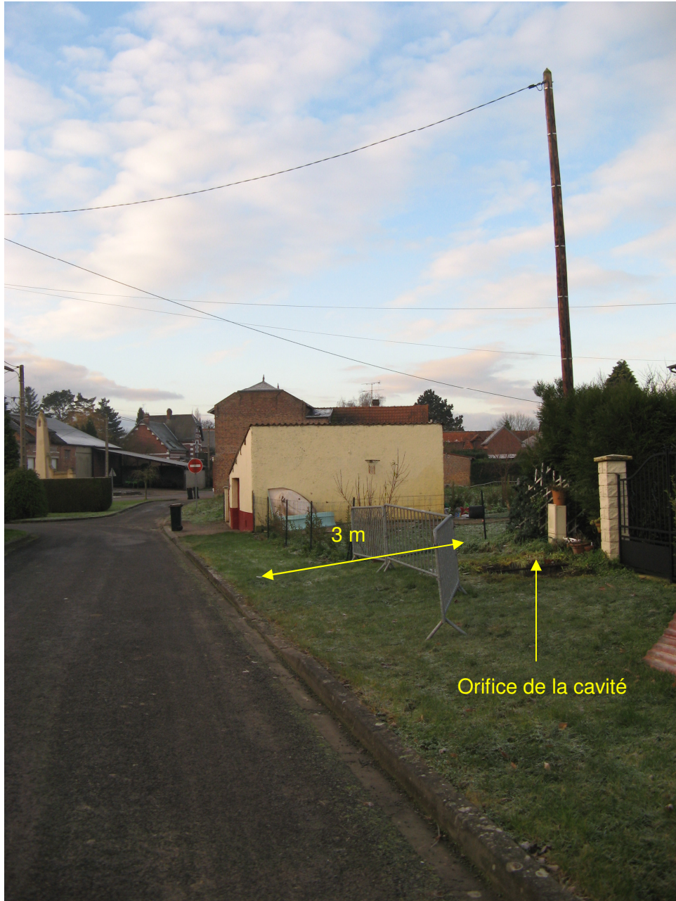
Illustration 5 : Photographie de la zone d'effondrement
