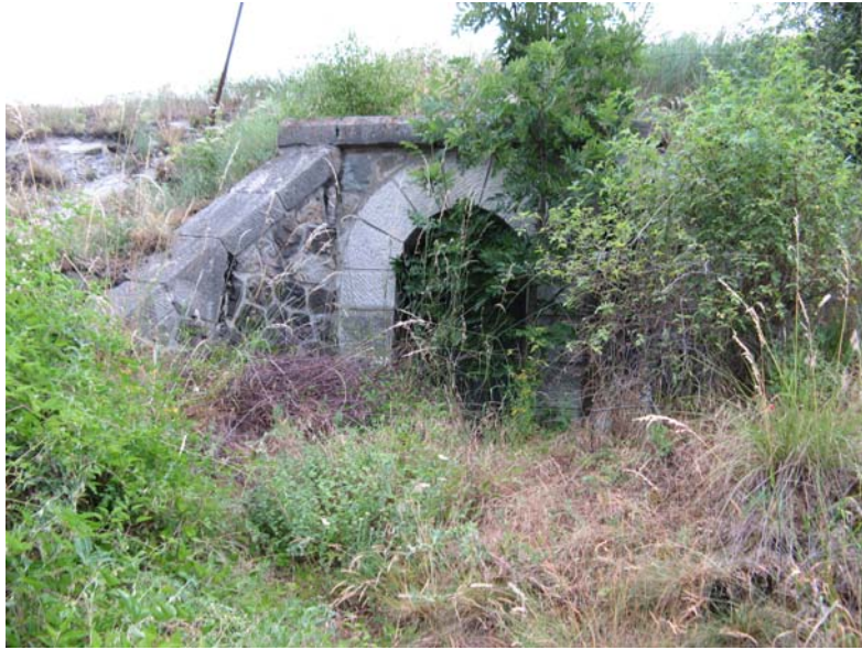
Illustration 23 – Ancien réservoir – commune de Tallard- PACAA1000663
