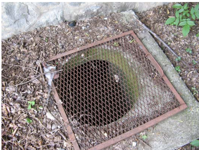
Illustration 22- Tunnel –Aqueduc de l'ancienne usine (alimentation en eau) – Commune de la Saulce- Fiche PACAA1000661
