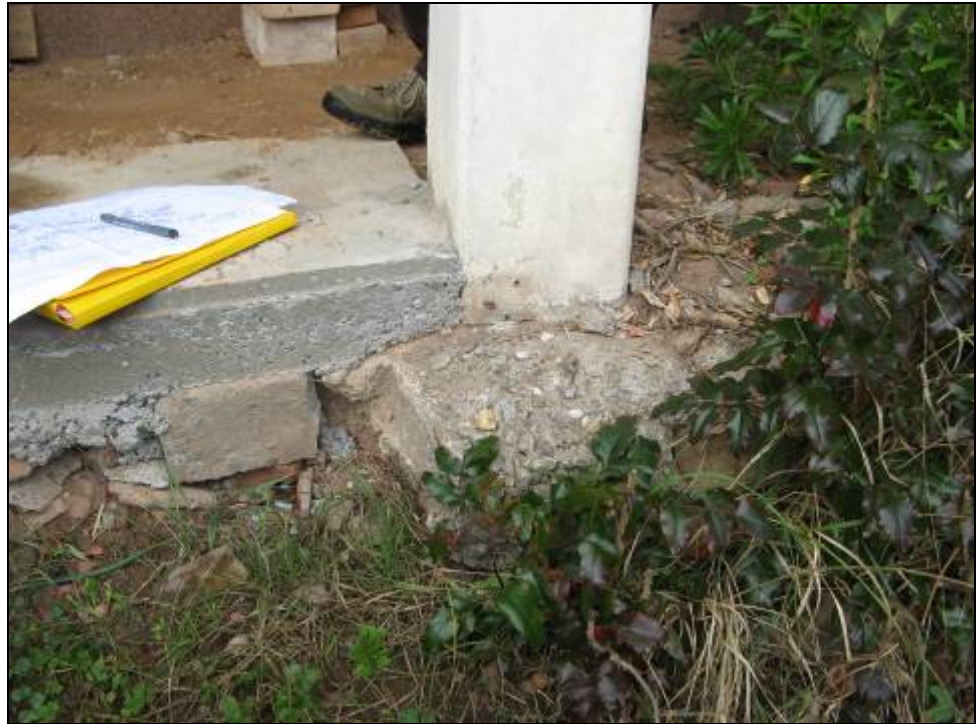
Photo 54 - Décapage naturel des terrains en bordure de la terrasse de la parcelle 157.
