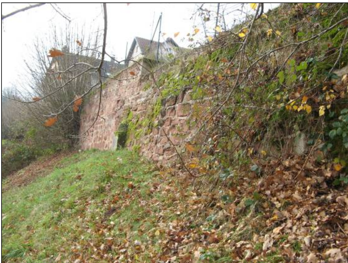
Photo 50 - Mur bombé en limite des parcelles 138 et 170.
