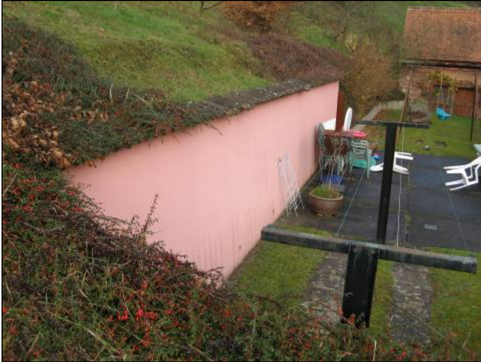
Photo 46 - Mur en bon état sur la parcelle 170.
