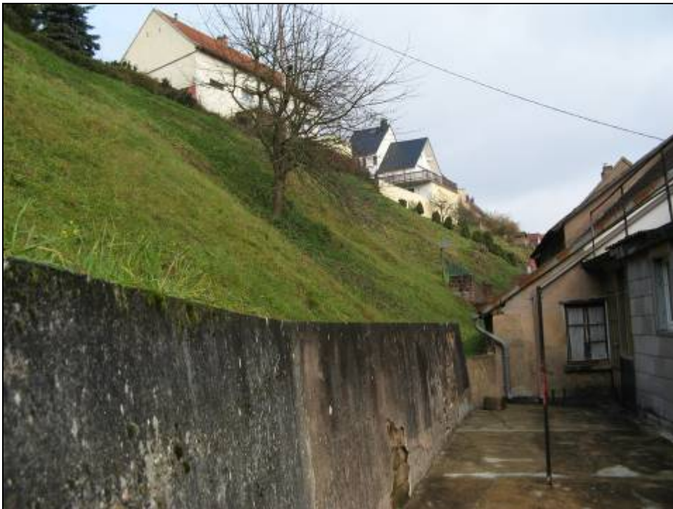
Photo 44 - Mur en bon état (excepté le vieillissement naturel du crépi) sur la parcelle 166.
