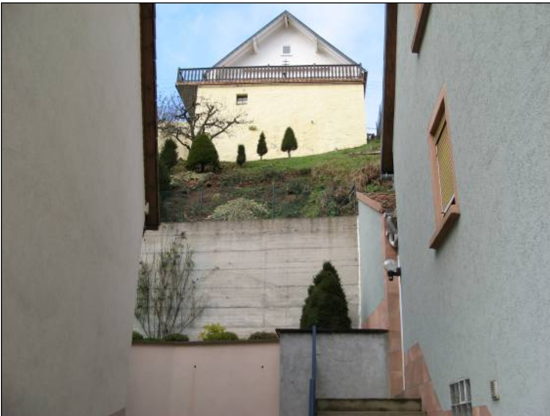
Photo 41 - Grand' Rue, mur en bon état sur les parcelles 161 et 162.
