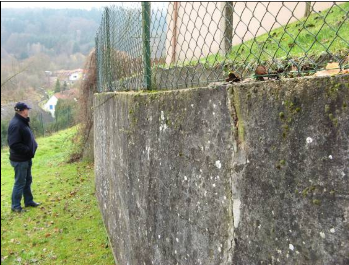
Photo 49 - Mur bombé sur les parcelles 136 et 137.
