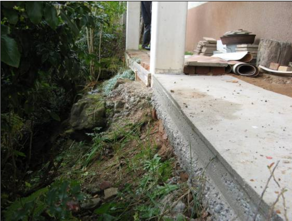
Photo 53 - Décapage naturel des terrains en bordure de la terrasse de la parcelle 157.
