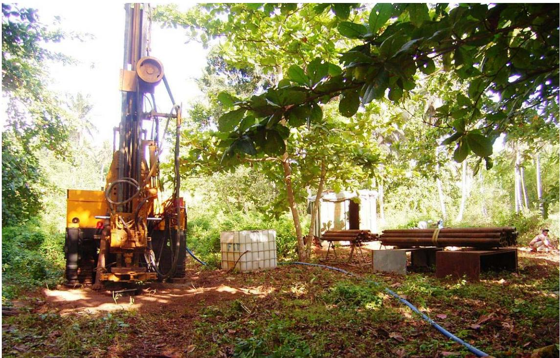
*Illustration 4 : La plateforme de forage du piézomètre de Dzoumognè 2 (photo BRGM)*
