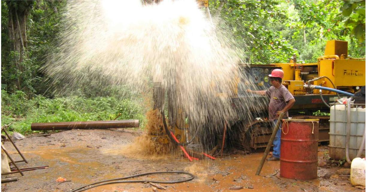
*Illustration 5 : Descente des tubages dans le forage (photo BRGM)*
