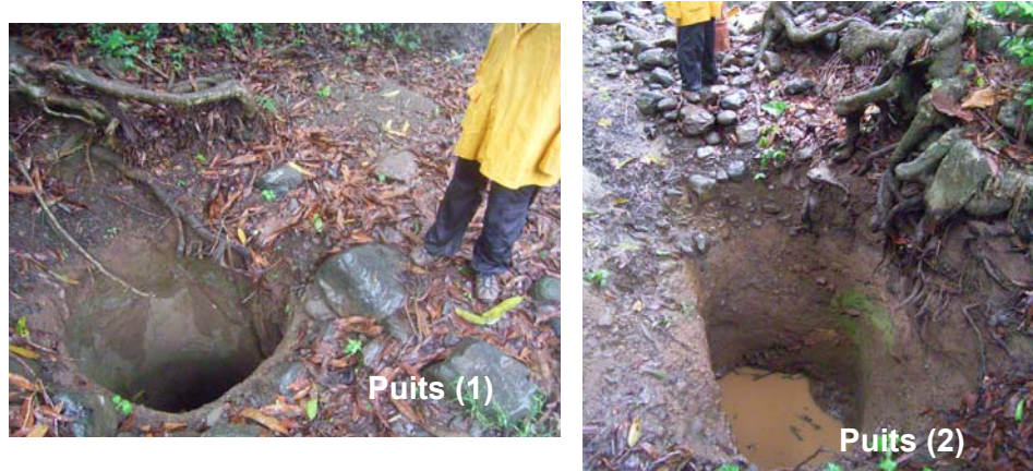
Figure 6 : Puisards (1) et (2) localisés aux points 9 et 10 dans la rivière
