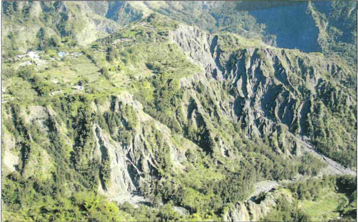
Figure 25 : Partie Nord d'Ilet à Vidot et versant rive gauche de la ravine Bras Sec
