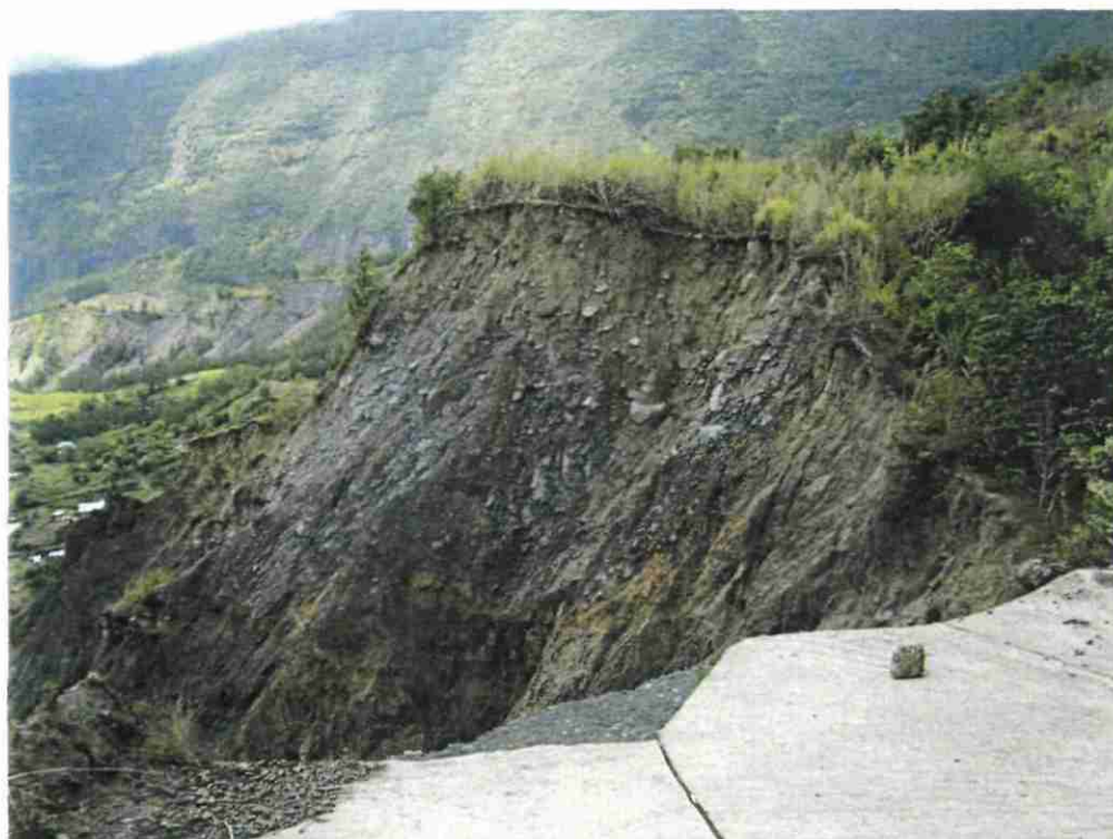
Figure 35 : point 10 – Recul d'une dizaine de mètres de la bordure Est de l'îlet suite à Gamède. Une partie du chemin menant à un élevage porcin a été emportée.
