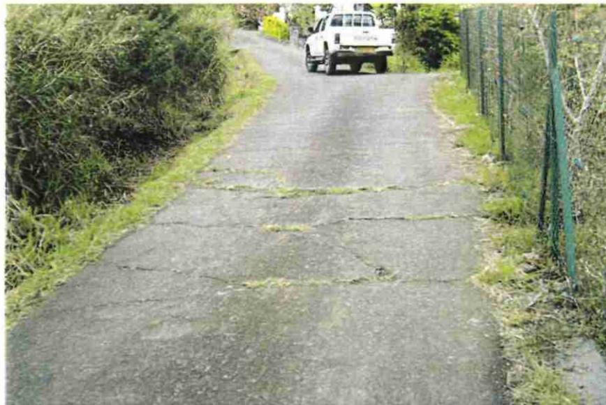
Figure 30 : Point 4 – Continuité vers l'Ouest de la faille visible sur la figure 3, au niveau du Chemin Manouilh
