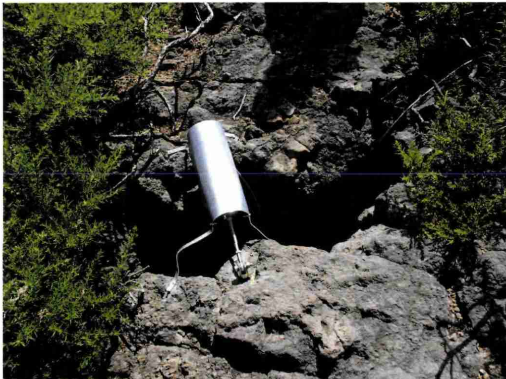
Illustration 13 – Fissure d'ouverture décimétrique sur le site du Maïdo
