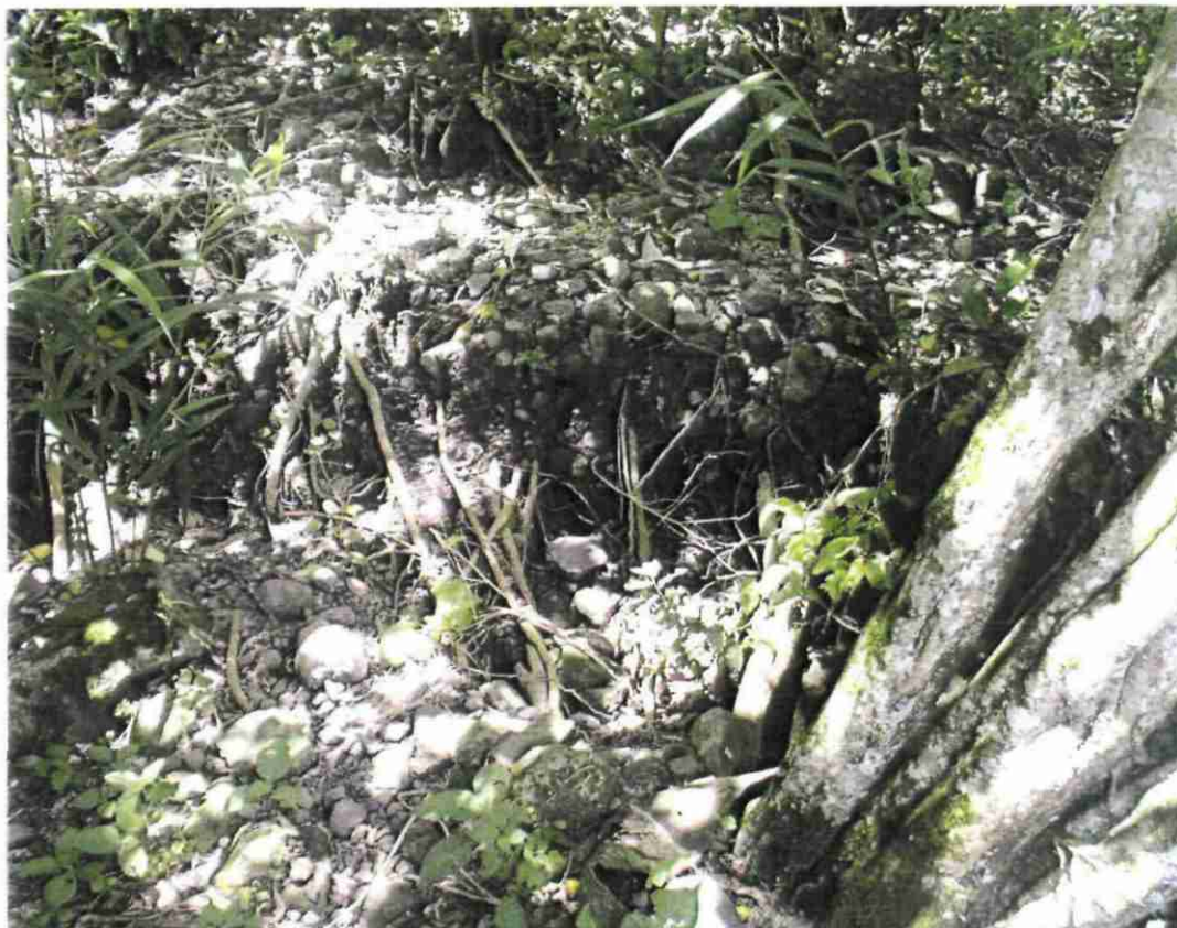
Figure 19 : « Crevasse » en bordure de la propriété Nourry (Chemin des Bringelliers). A noter les racines tendues au premier plan
