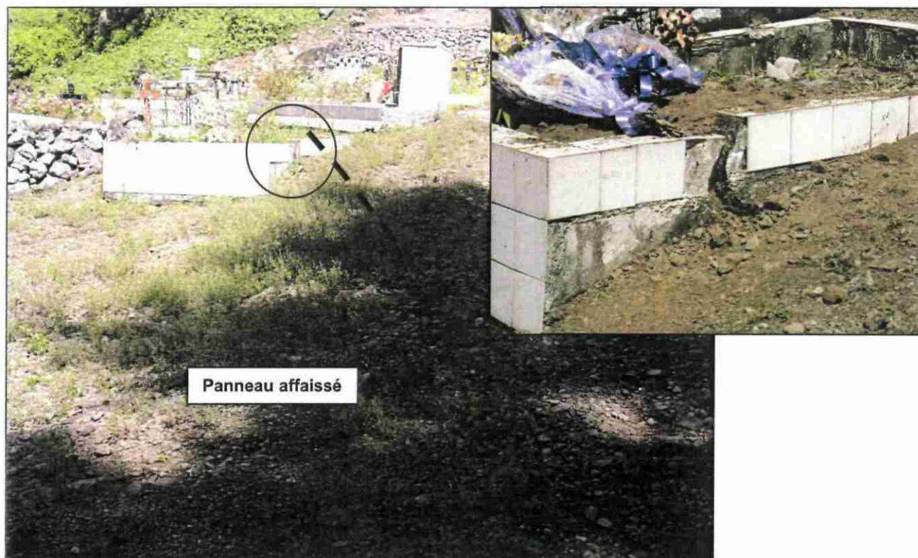
Figure 31 : Décroché en bordure nord du cimetière (rejet décimétrique)
