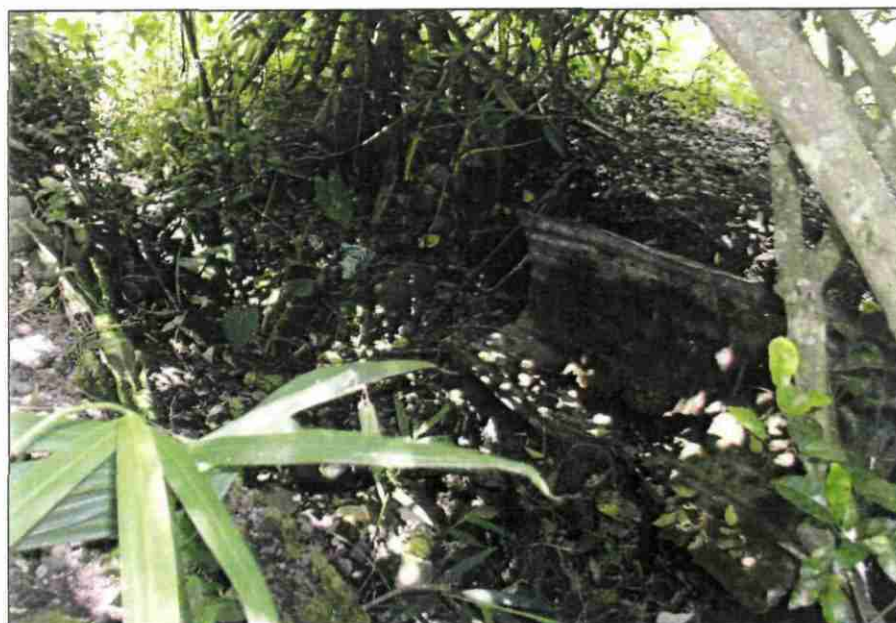
Figure 20 : « Crevasse » en bordure de la propriété Nourry (Chemin des Bringelliers), rejet métrique et ouverture plurimétrique
