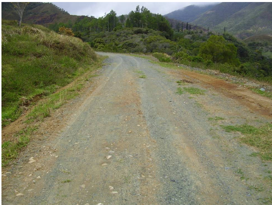
Photo 22 : Piste recouverte de serpentine, col de Nérin, commune de Houaïlou
