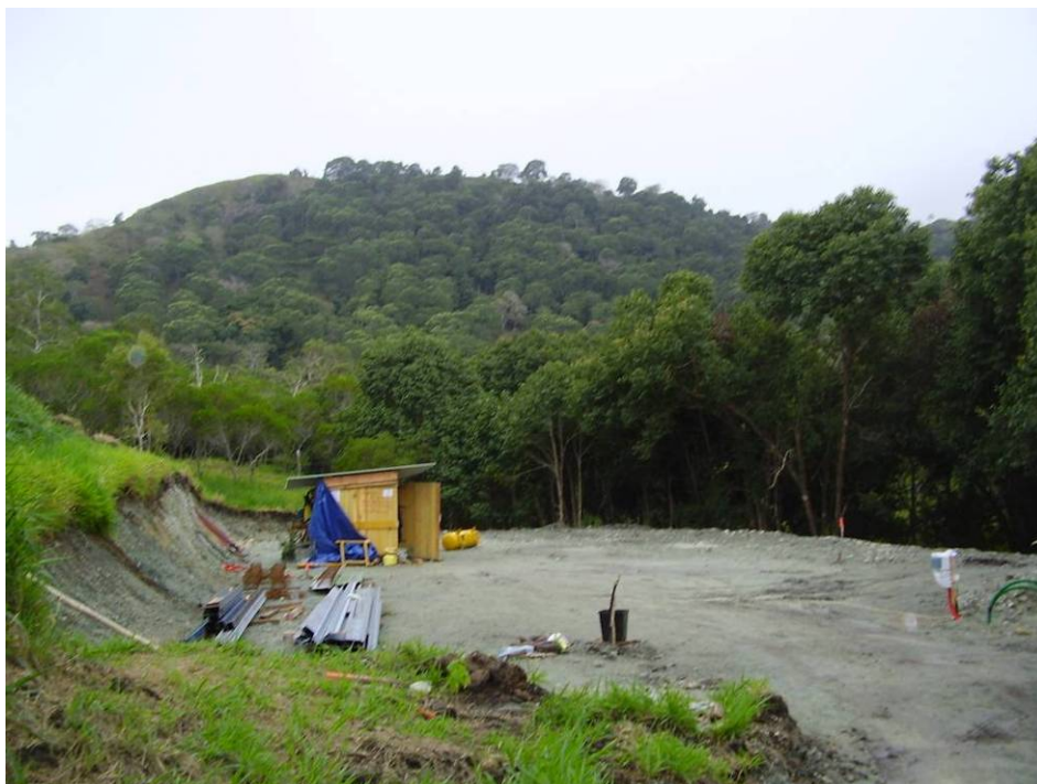
Photo 10 : Plateforme d'habitation dans des formations de serpentinite, commune de La Foa
