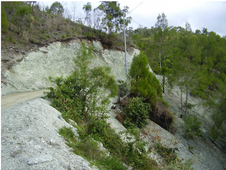
Photo 24 : Piste en déblais-remblais traversant une formation de serpentine, à proximité de la tribu d'Atéu, commune de Koné
