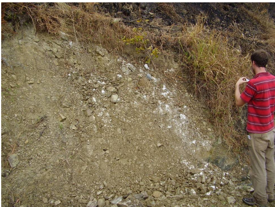
Photo 21 : Talus routier comportant une strate de « terre blanche », en bordure de piste d'accès au col de Nérin, commune de Houaïlou
