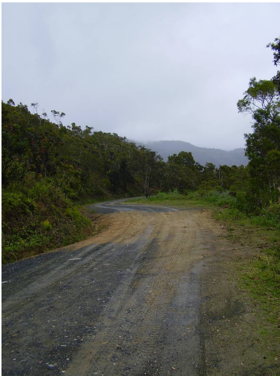
Photo 26 : Piste recouverte de serpentinite, entre Bas Coulna et Ouyagette, commune de Hienghène
