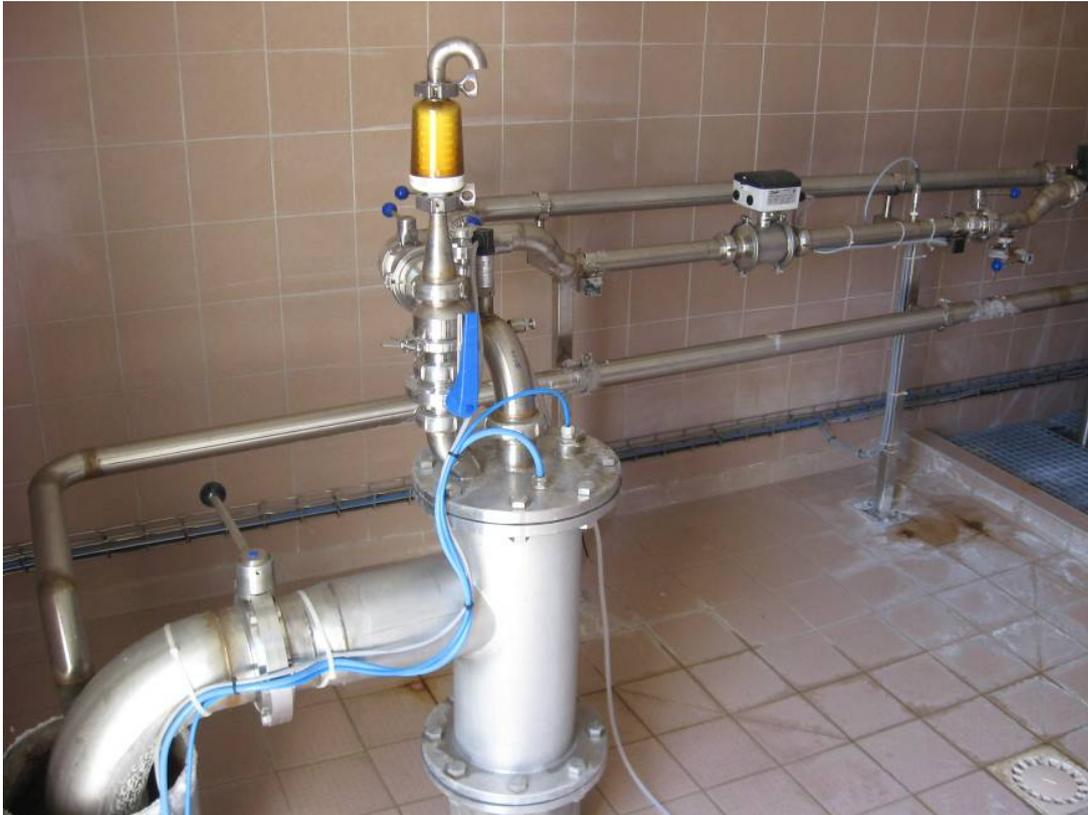
*Figure 33 : Tête de puits du forage Lithium à Santenay.*
