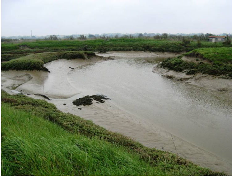
Illustration 23 - Erosion de berges sur la commune du Fenouillet
