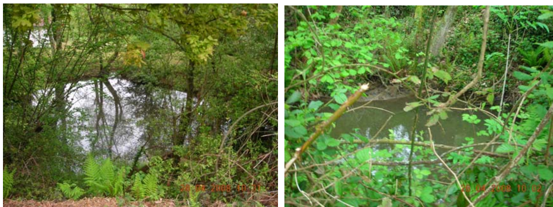
Illustration 16– Effondrement inondé de l'ancienne carrière souterraine de gypse (commune Lamarque-Pontacq)
