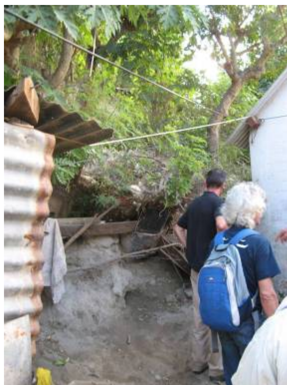
Talus 2 – Installation en pied de talus et tentatives de maintien des terres.
