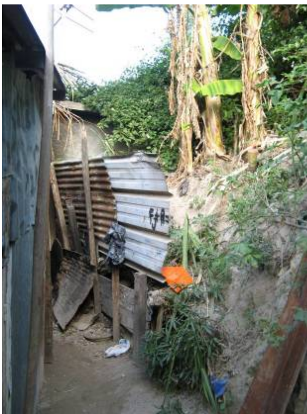
Talus 2 – Installation en pied de talus et tentatives de maintien des terres.
