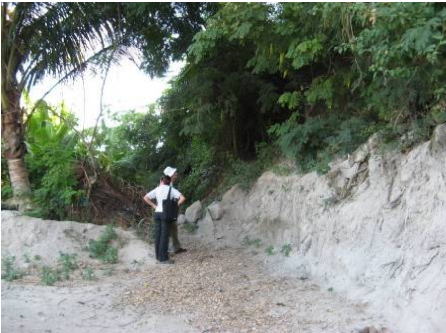
Talus 1 - Décaissements effectués en pied de talus (noter les blocs en présence).
