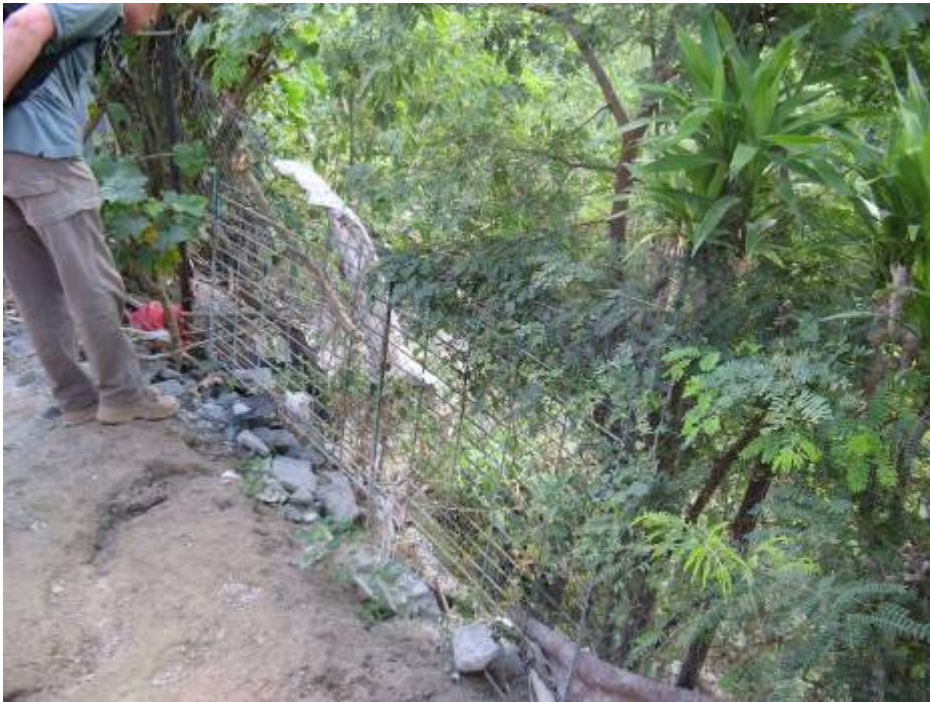
Sommet du talus 2 au niveau duquel sont rejetées les eaux d'un assainissement autonome.
