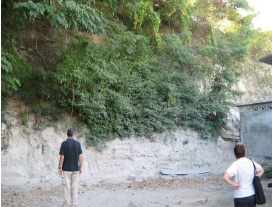
Extrémité Sud du talus 1.
