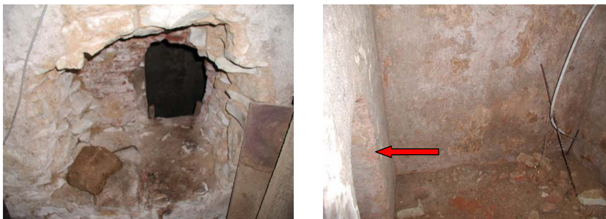
Figure 22– Souterrain refuge sous une habitation dans la commune de Murs. La flèche rouge indique l'entrée d'une salle souterraine. (Photo BRGM)
