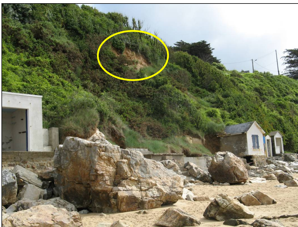
Illustration 10 : Déstabilisations de terrain sur le talus en amont des cabines abandonnées
