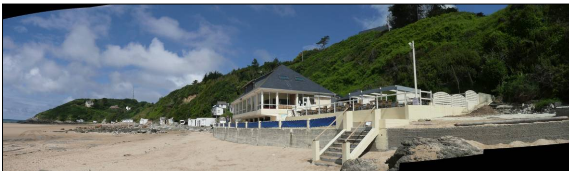
Illustration 9 : Vue depuis l'entrée de la plage de l'ensemble du talus depuis le restaurant jusqu'à l'extrémité de la plage à l'Ouest
