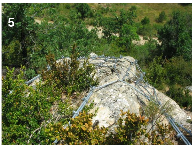
Illustration 14 : Observations réalisées sur les blocs issus des éboulis stabilisés et éluvions – 1 : éluvions englobant les blocs ; 2 : bloc fracturé ; 3 : câbles ; 4 : ancres ; 5 : emmaillotage.
