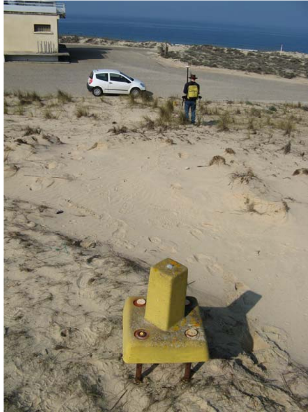
Figure 9 : Borne L4a déchaussée sur dune mobile
