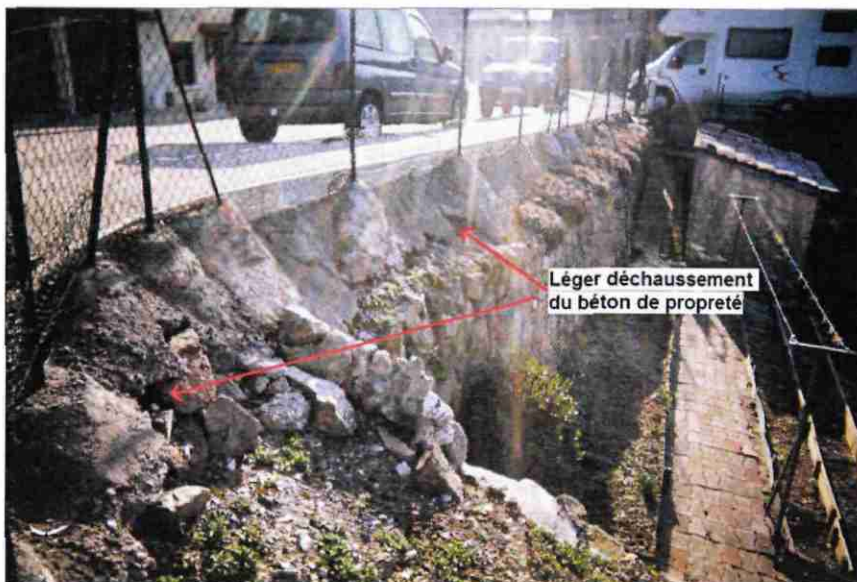
Illustration 7 : Phénomène de déchaussement du béton de propreté au-dessus de la parcelle n° 138 (15 février 2008, photo BRGM)
