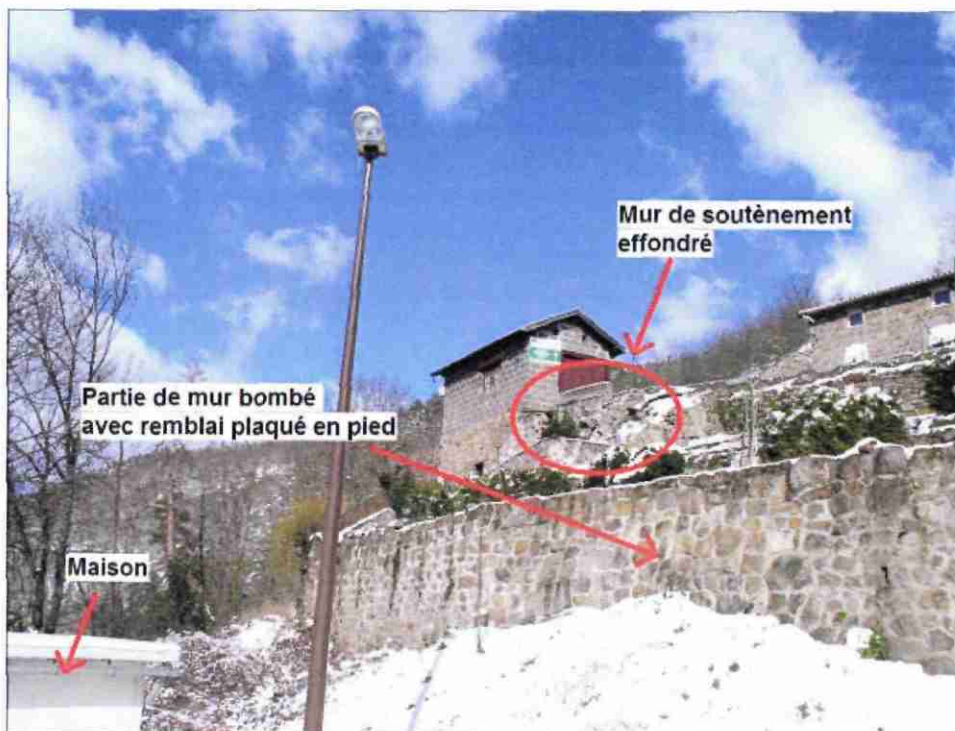
Illustration 12 : Aperçu du site le 5 mars 2008 depuis le bas (photo BRGM)
