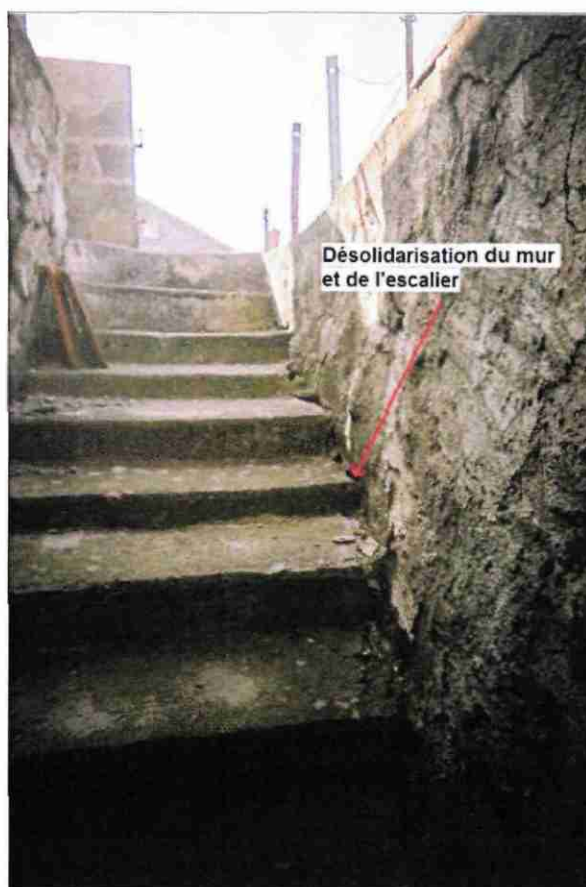
Illustration 7 : Phénomène de déchaussement du béton de propreté au-dessus de la parcelle n° 138 (15 février 2008, photo BRGM)
