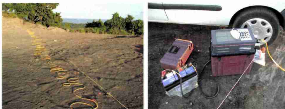
Figure 19 : Dispositif SASW (à gauche : « flûte » de géophones, à droite : station d'acquisition)
