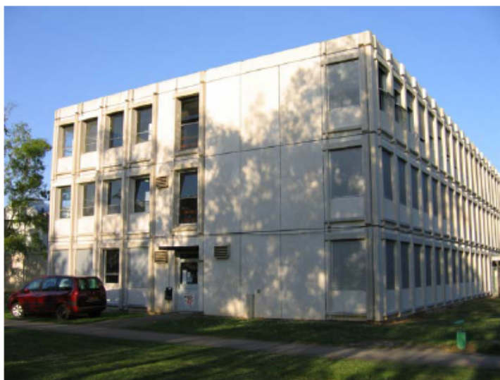
Figure 1 : Bâtiment du génie civil de l'IUT d'Amiens
