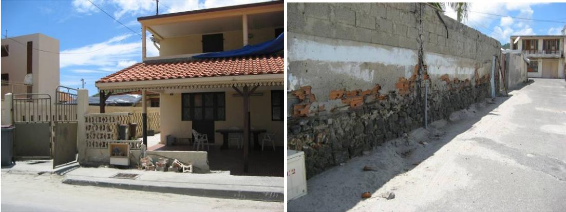
*Illustration 25 : Au Vauclin, mur en partie détruit par les vagues et traces de dépôts de sable dans les rues*
