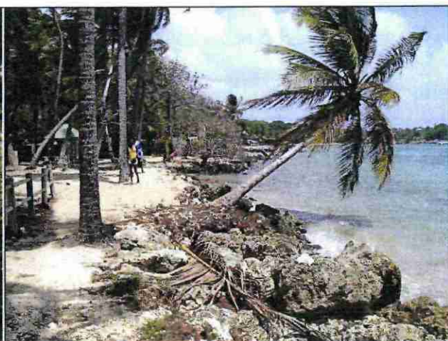
Photo 4- Côté est : Enrochements endommagés et travaux de réaménagement en cours (zones remblayées à l'arrière).
