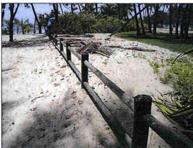
Photo 3- Côté est : Large surverse sur le gazon en arrière-plage.
