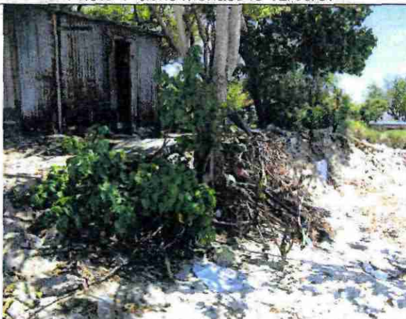
Photo 4- Erosion à l'extrémité est le 12/09/07
