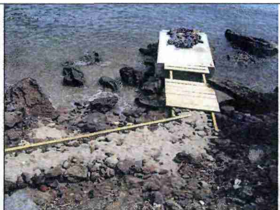
Photo 2- Ponton de Grande baie le 18/09/07
