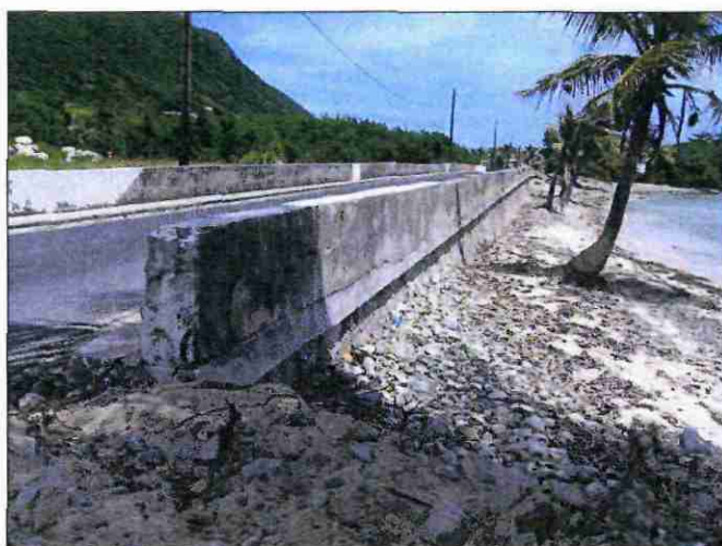
Photo7 & 8 – Base affouillée du pont enjambant la saline à l'est du bourg (à g.) - & - Bouchon formé à la jonction mer-saline sous le pont (à d.).
