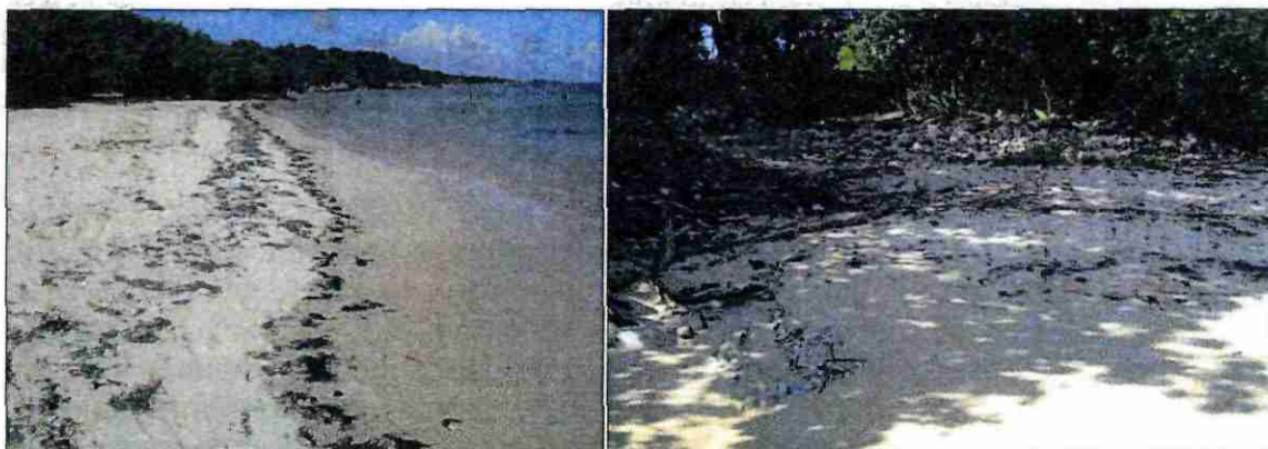
Photo 1 & 2 – La plage d'Anse Loquet (à g) & Accumulation de débris rocheux en fond de plage (à d.).
