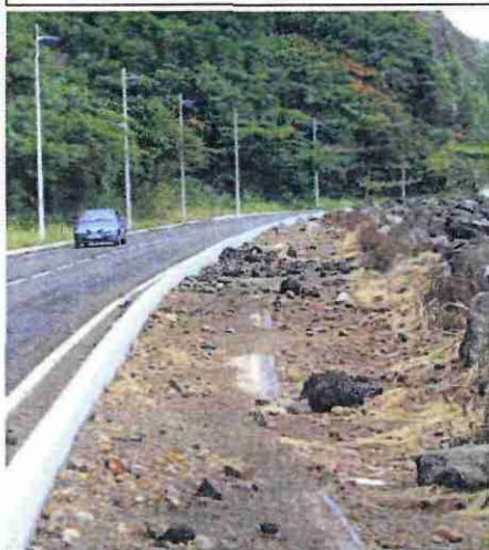
Photo 3 – Enrochement à concavité vers la mer & débris associés à cette configuration.
