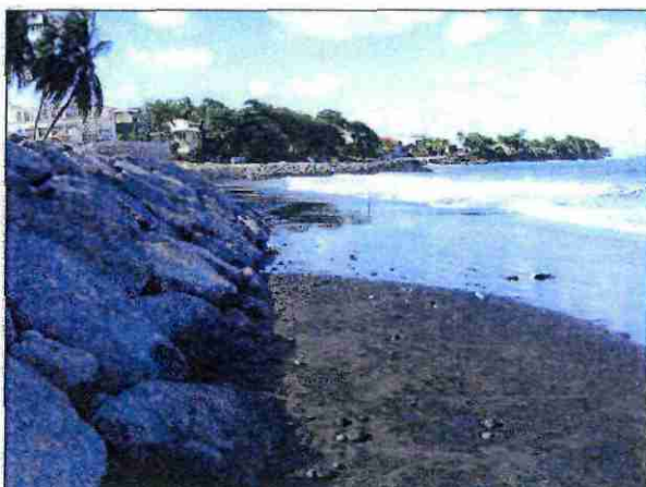
Photo 1 – Enrochements du nord de plage.
