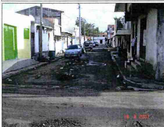
Photo 3 Ruelle à proximité de la mairie.
