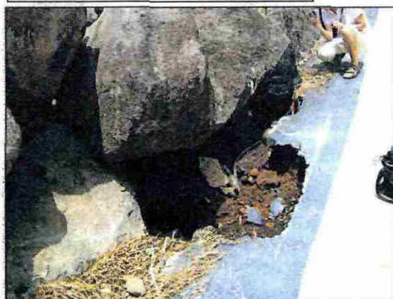
Photo 3 – Enrochement à concavité vers la mer & débris associés à cette configuration.
