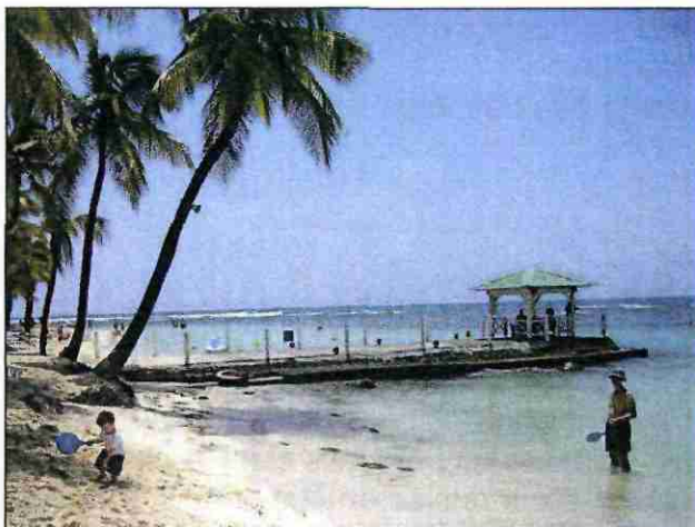
Photo 1- Côté ouest : Enracinement d'épi endommagé et talus d'érosion au pied des cocotiers.
