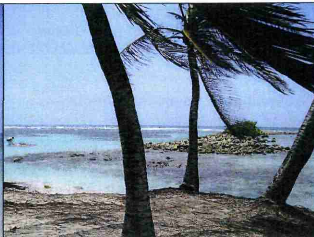
Photo 2- Pointe de l'Accul : Large brèche au niveau de l'enracinement de l'épi et érosion au pied des cocotiers.
