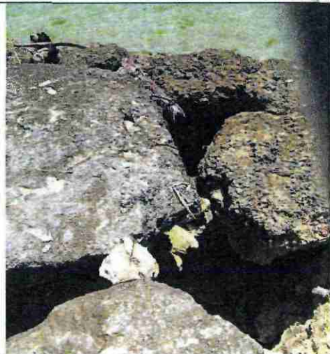
Photo 2- vue détaillée de l'ouvrage
