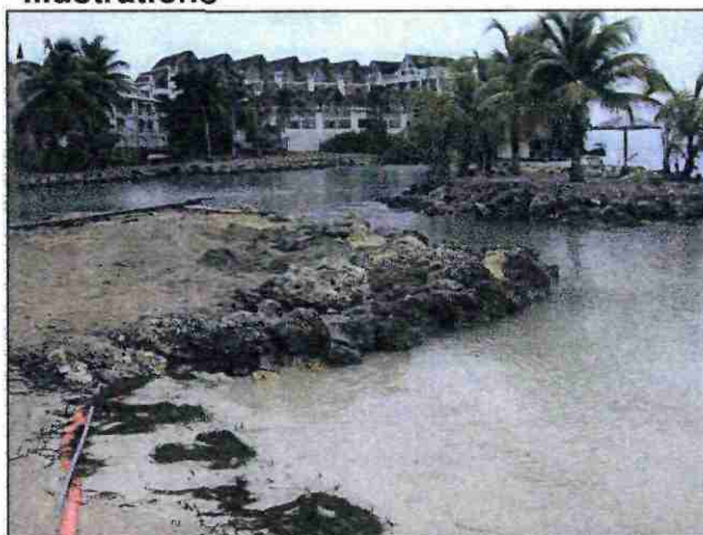
Photo 1- Ilet isolé suite à la destruction de la passerelle.
