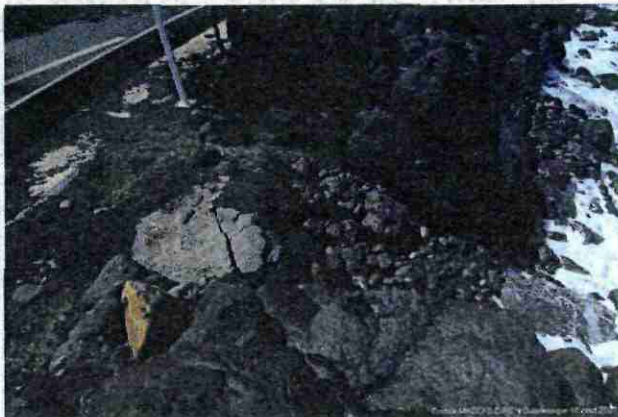
Photo 2 – Enrochement endommagé.
