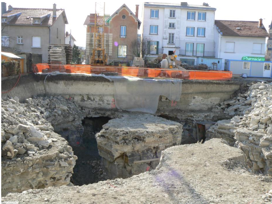
Illustration 9 - Galeries souterraines d'extraction de calcaire, avenue Pochet Lagaye à Clermont-Ferrand (cliché BRGM, février 2007)
