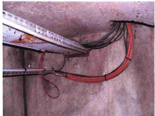
Figure 37 : Extrémité (section 6) point de sortie ou d'entrée des gaines techniques sous le transformateur
