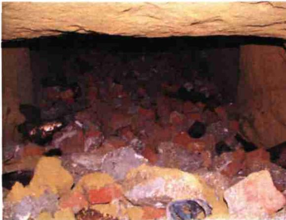
Les trois tronçons pairs sont équipés de cheminées à partir desquelles il est possible de calculer ou d'évaluer l'épaisseur des terrains de recouvrement. Seule la cheminée du tronçon 4 a été ouverte en surface. Dans certains secteurs, les effondrements de voûte naissent sur ces niveaux durs, laissant apparaître en relief les blocs calcaires.
