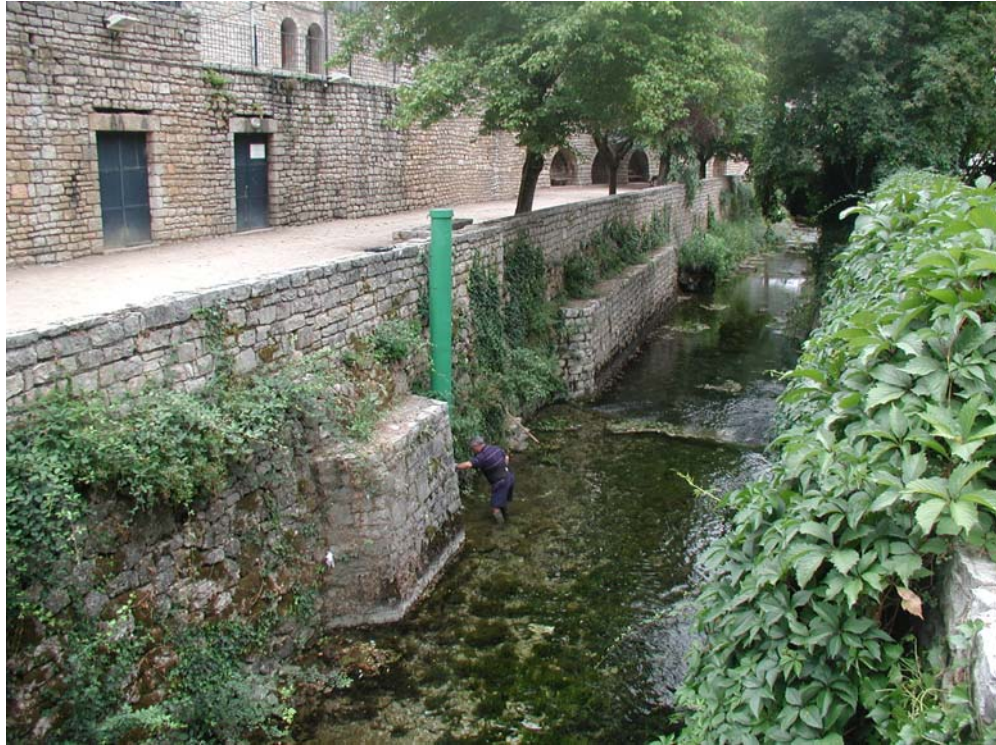
Illustration 26 - Canal de Burle et station de mesure.
