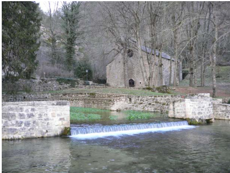
Illustration 16 – Saint Frézal (avant séparation de l'écoulement).
