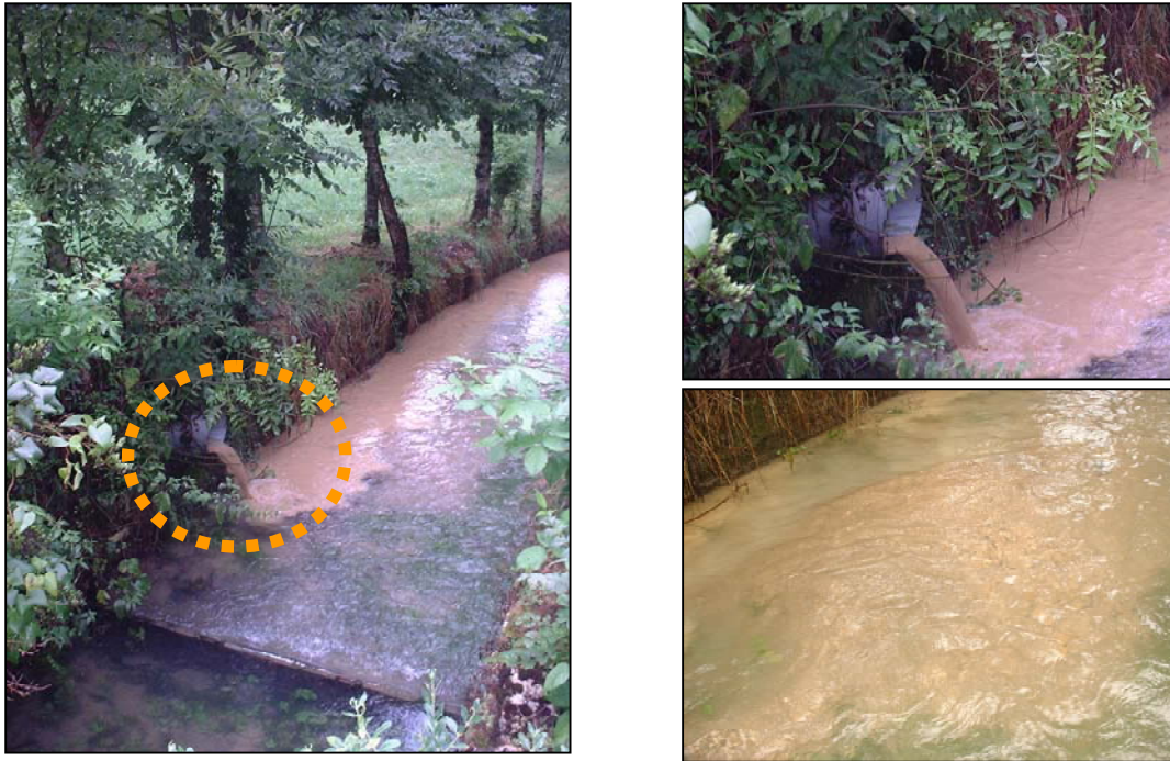
Illustration 37 - Déversement des eaux pluviales chargées en sédiments à l'aval direct du seuil de jaugeage.
