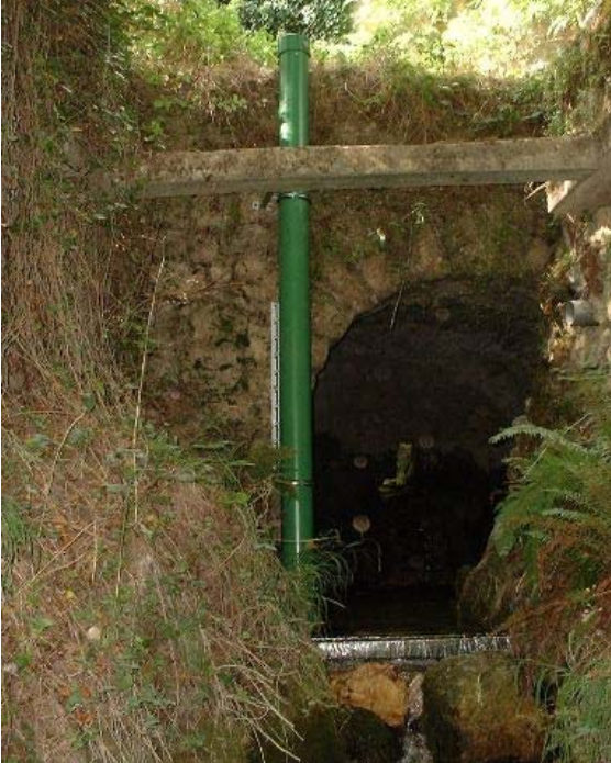
Illustration 15 - Ouvrage de la source d'Angle
