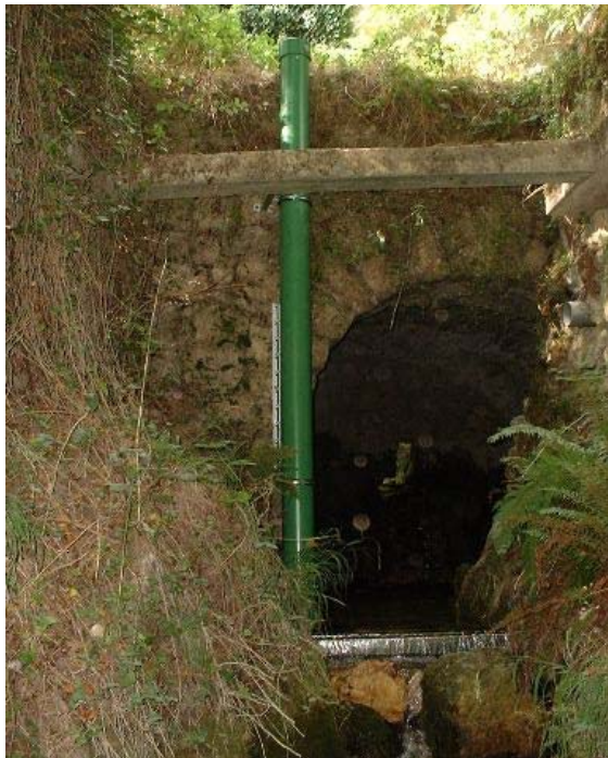
Illustration 3 – Ouvrage de la source d'Angle
