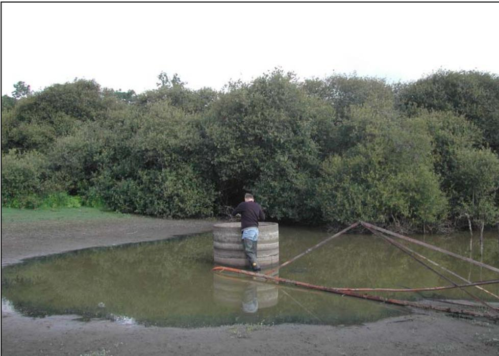
Ouvrage utilisé pour l'alimentation du bétail, nappe affleurante
