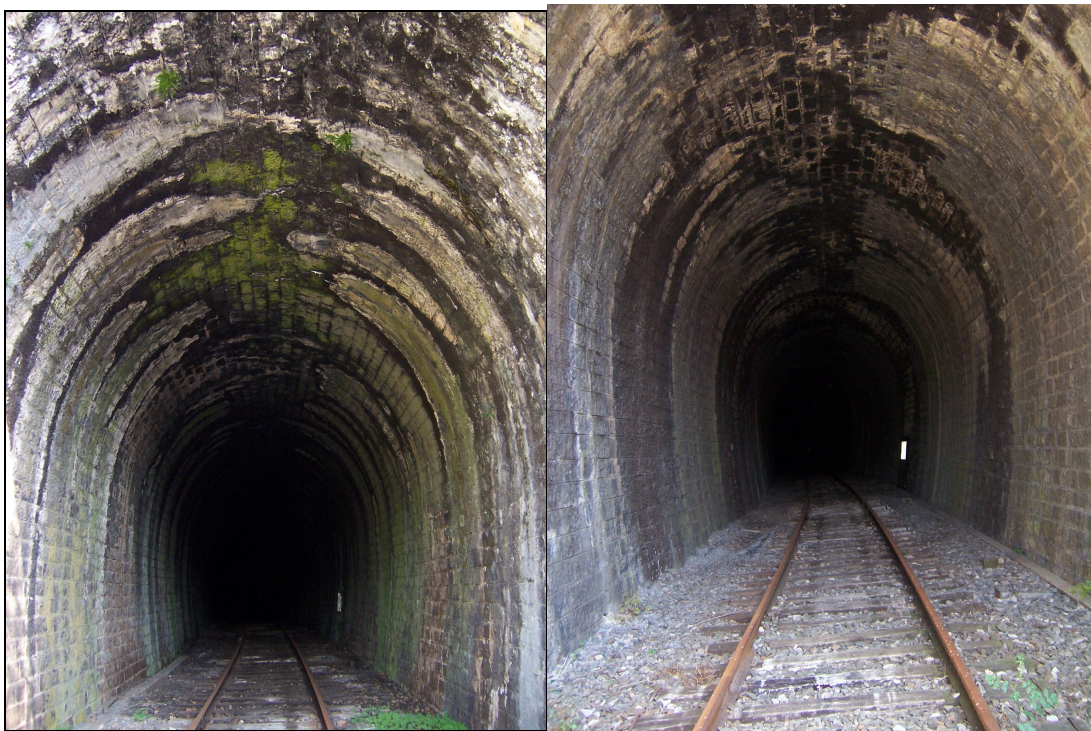
Illustration 11 – Tunnels ferroviaires abandonnés (communes de Bouziès et Montbrun)
