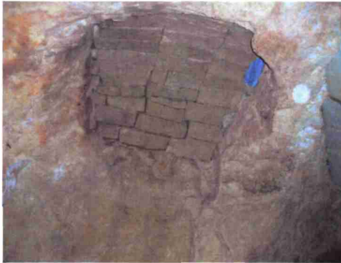
Illustration 28 – Cavité n°17_Nord – Puits obturé en bordure de la tête du pilier
