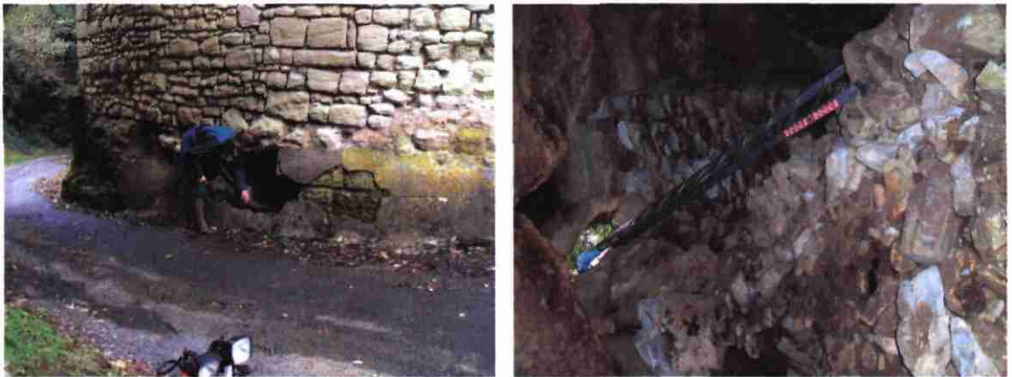
illustration 29 – Cavité n°13 – Photos de son accès
