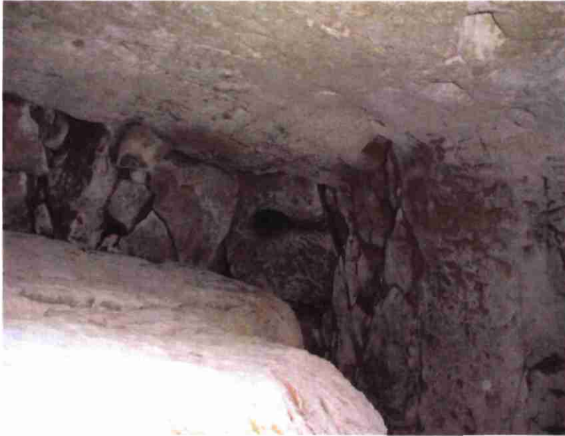
illustration 8 – Cavité n°42 bis (Sud) – Chemin rural – Ouverture au toit obturée par blocs
