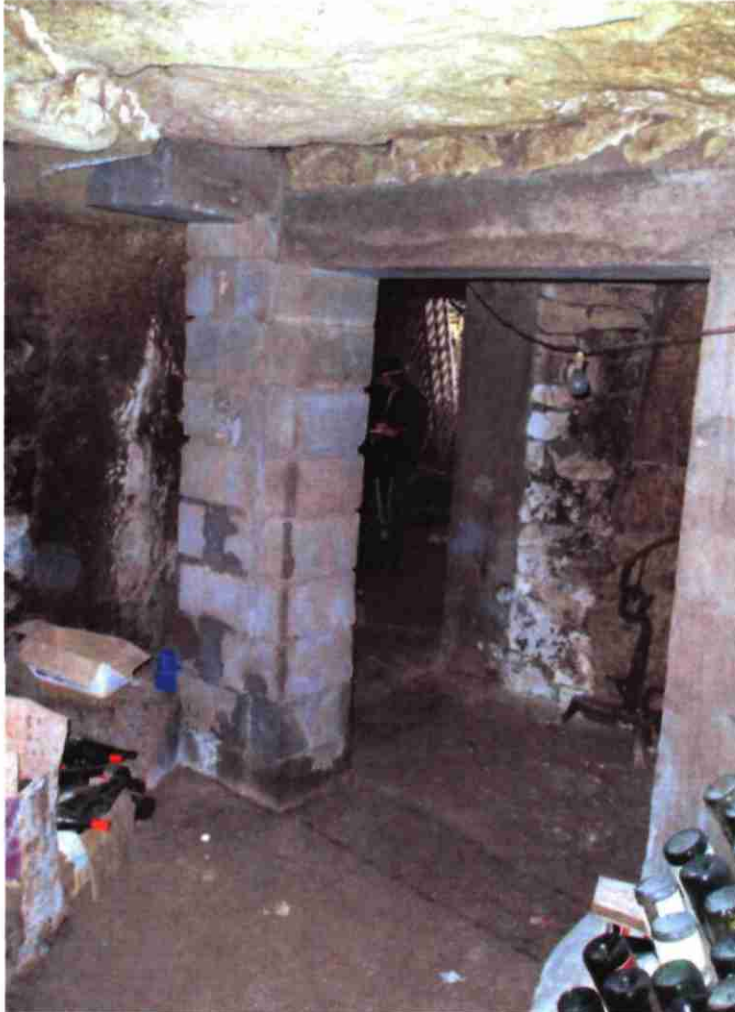
Illustration 1 – Cavité n°41 – Rue des Perrières – Confortements du niveau supérieur à l'aplomb de la rue
