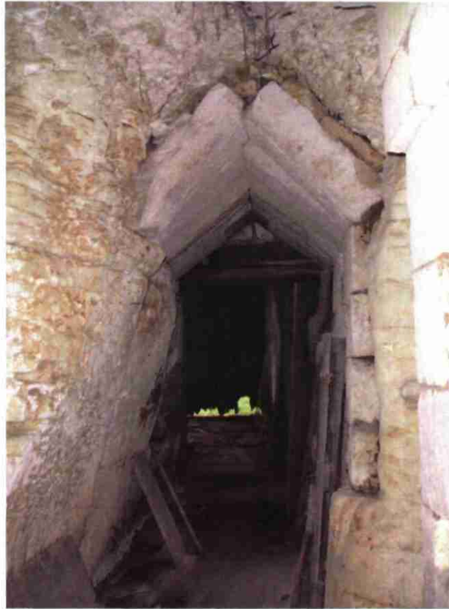
illustration 7 – Cavité n°42 – Chemin rural – Couloir d'entrée
