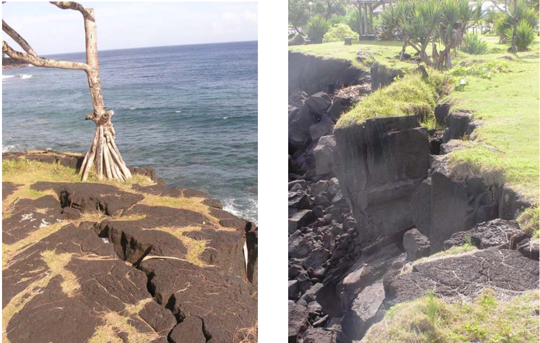
Illustration 29 – Fracturation et basculement de pans de falaise à la Mer Cassée
