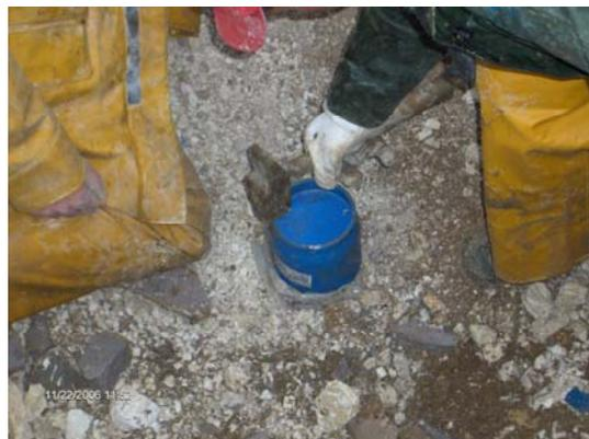
Figure 11 – Rebouchage du piézomètre de Pauvres (08)
