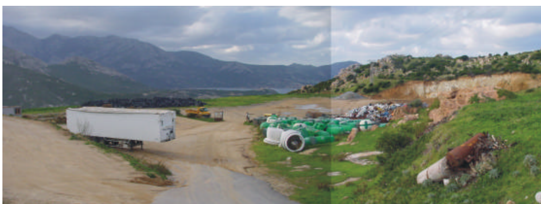
Illustration 8 : Photographie du site de la déchetterie de Notre-Dame de La Serra.
