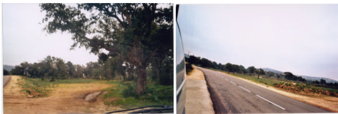
Illustration 109 : Photographie du site d'Arasu : vue du site (à gauche) et desserte (à droite).
