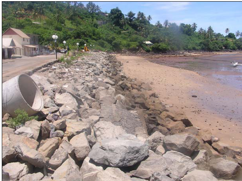
Illustration 22 - Enrochement au Sud de la plage (février 2006 – mission BRGM/GEODAL)
