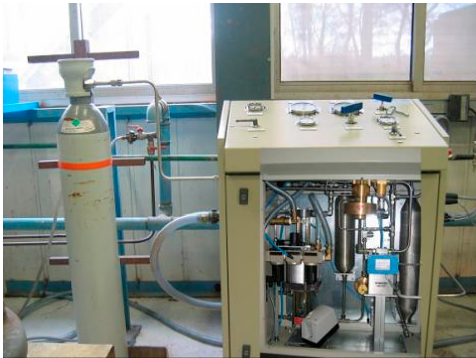
Figure 10 – Banc d'essai des autoclaves
