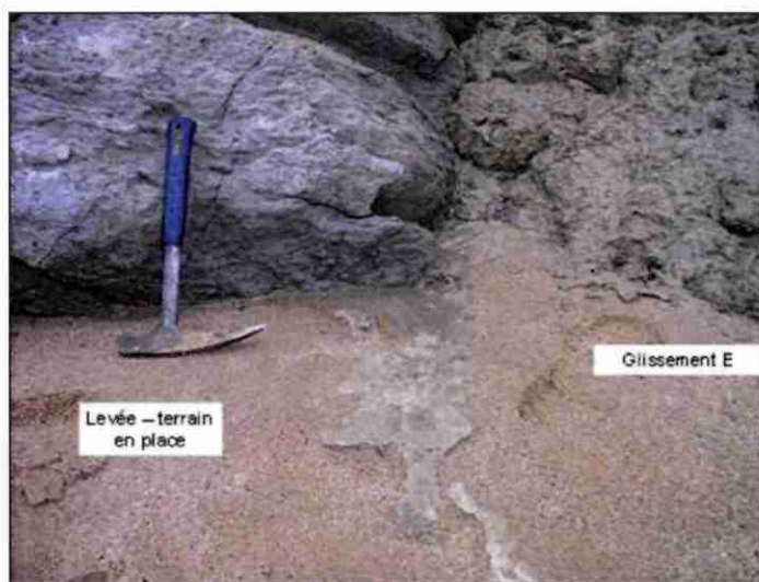
Figure 60 : Vue d'eau observée au pied du glissement ( décembre 2004)
