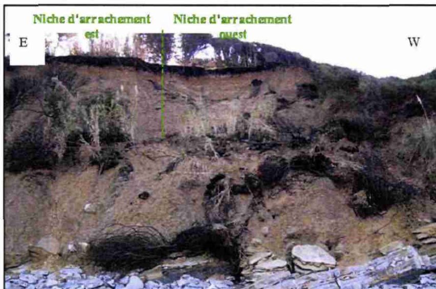
Figure 31 : Glissement de janvier 2004 sur les falaises de Guéthary
