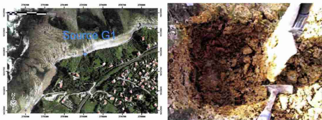
Figure 23 : Arrivée d'eau au sein des altérites en place. A droite : localisation de la venue d'eau (fond cartographique : © ORTHOLITTORALE 2000) ; à gauche : venue d'eau
