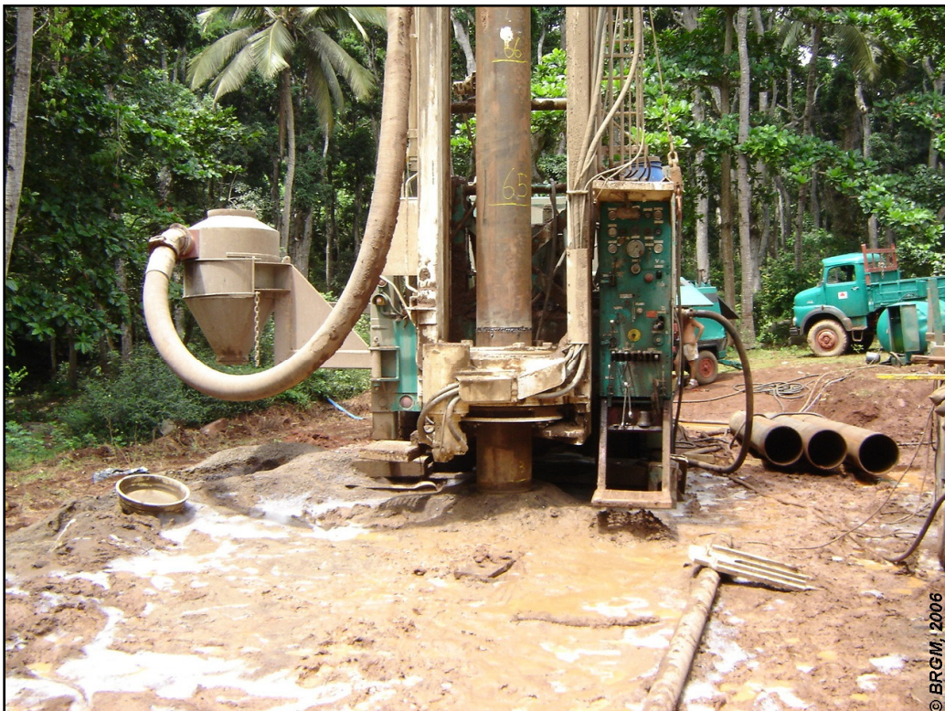
Illustration 2 : Photographie du chantier en cours de foration
