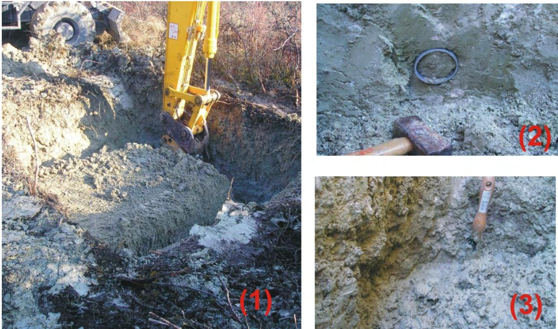
*Illustration 68 – Ouverture d'une fouille à la pelle sur le site expérimental de Mormoiron en février 2006 (1) : faciès argileux (2) et venue d'eau dans un faciès plus silteux (3) à 2 m de distance et à la même profondeur (1,70 m)*
