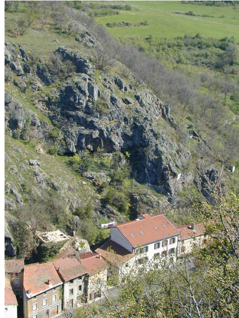
Illustration 13 : Zone à risque de chute de rochers à Saint-Floret
