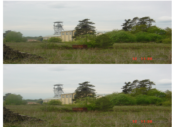
Illustration 16 : Ancien puits de mine à Messeix
