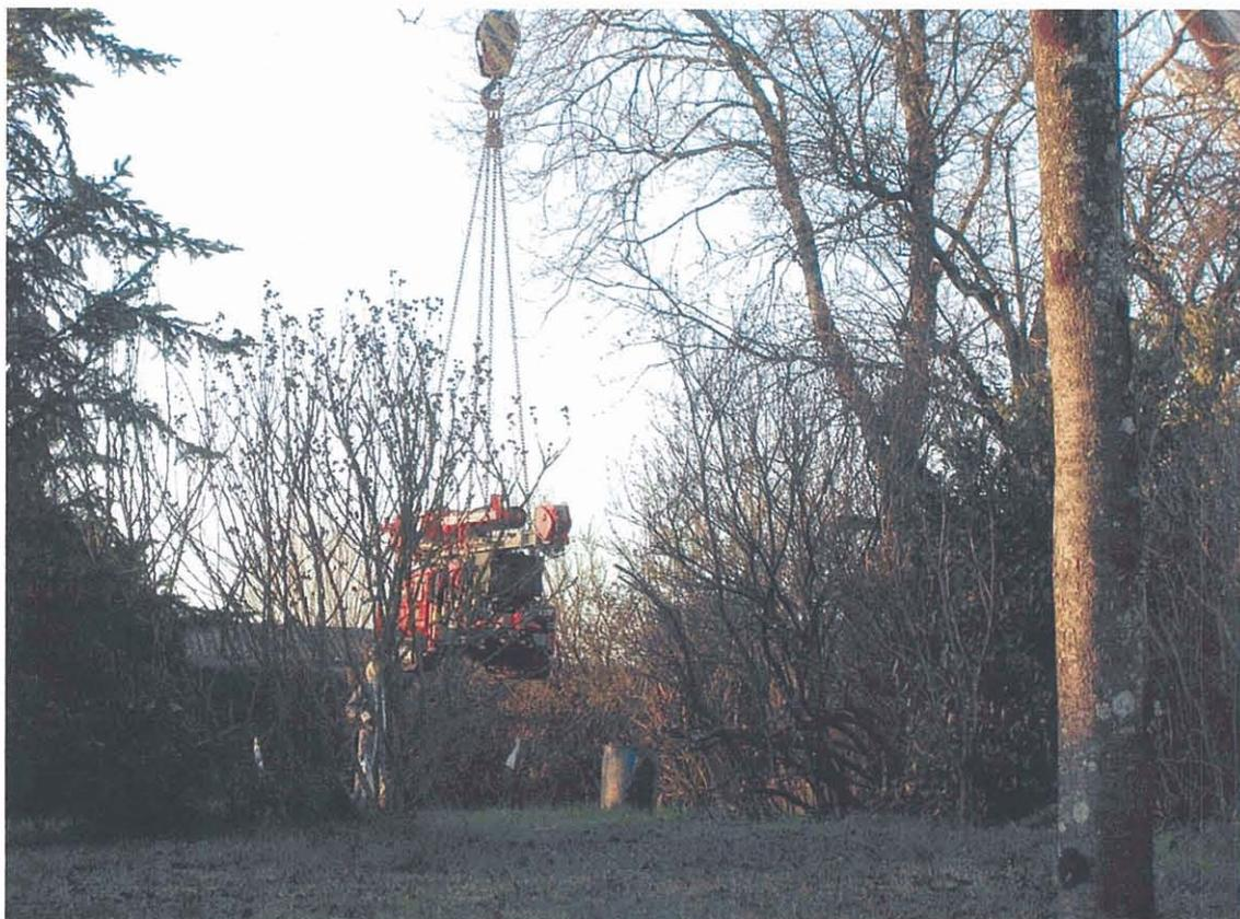
Photo 1 – Carrière "Nord-Est, St-Georges-des-Coteaux" - Grutage de la sondeuse
