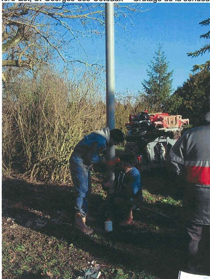
Photo 2 – Carrière "Nord-Est", St-Georges-des-Coteaux - Mise en place d'un tubage PVC Ø120
