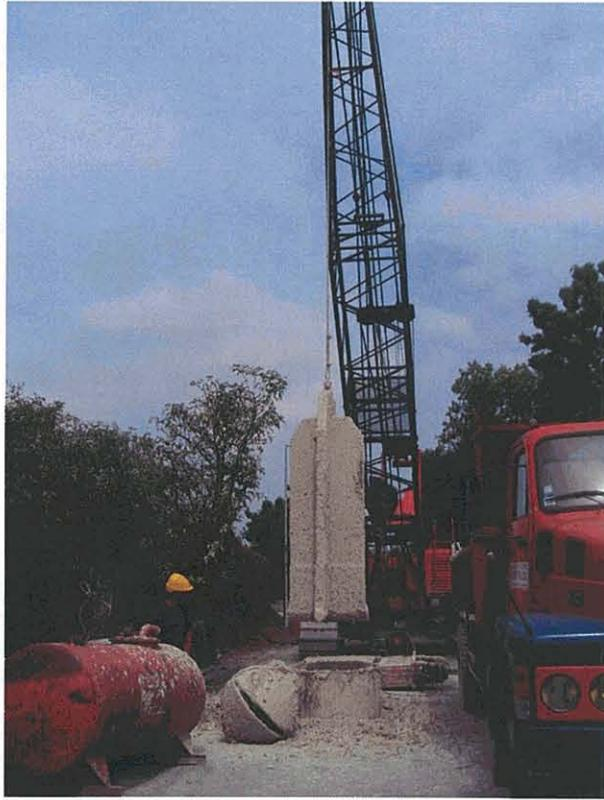
Photo 7 – Réalisation du puits de Ø 1000 - Taillant
