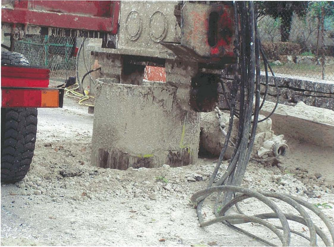
Photo 9 - Réalisation du puits de Ø 1000 – Vibro-fonçage du tubage métallique
