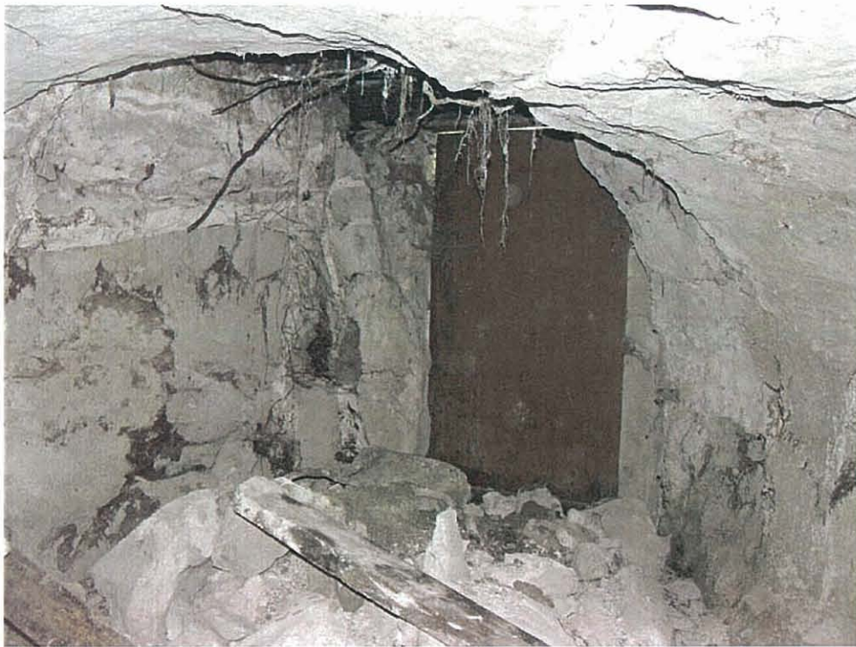
Illustration 45 : Décollement de la voûte dans le souterrain de Tourliac au lieu-dit Claud
