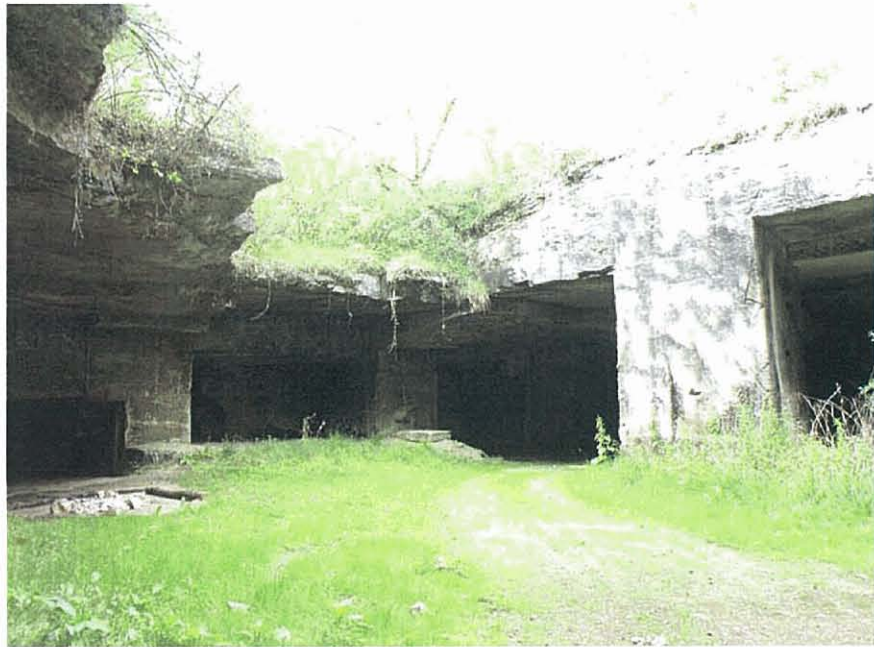
Illustration 42 : Accès 1 de la carrière souterraine abandonnée de la commune de Fumel au lieu-dit Pech du Treil
