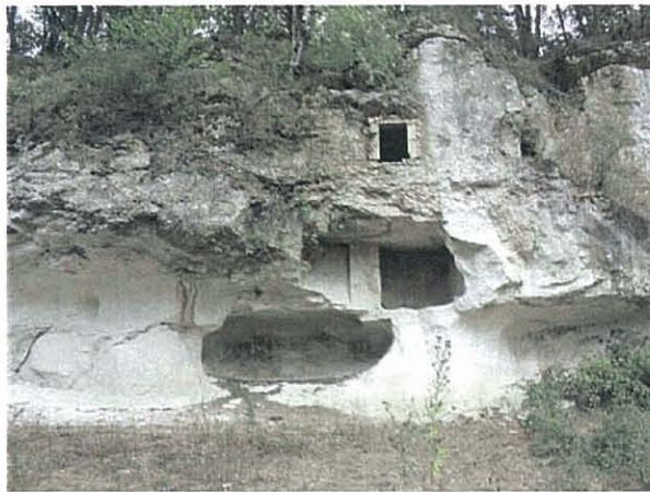
Illustration 6 : Ancien habitat troglodytique sur trois niveaux sur la commune de Saint-Hilaire de Lusignan au lieu-dit Gentillas, les deux premiers niveaux étant en partie effondré
