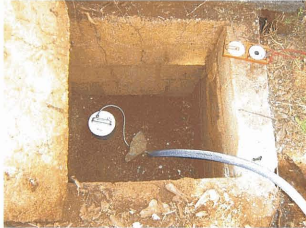
Illustration 3 – capteur (sismographe) installé à l'extérieur de la salle informatique
