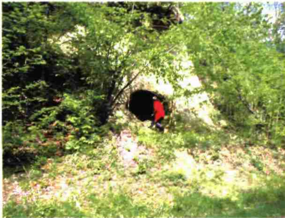
III. 16 - Entrée des carrières de molasse à Challonges –vue globale
