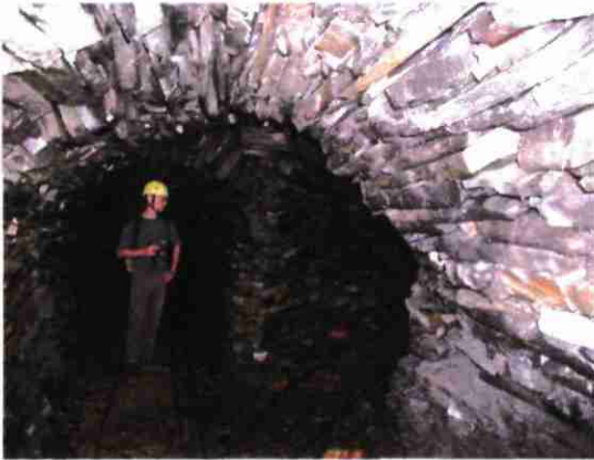
III. 12 – Ancienne galerie d'exploitation – Ardoisières de Morzine
