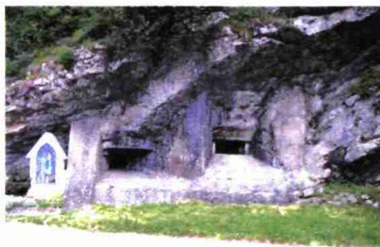
III. 22 – Fenêtres de tirs à Thônes
