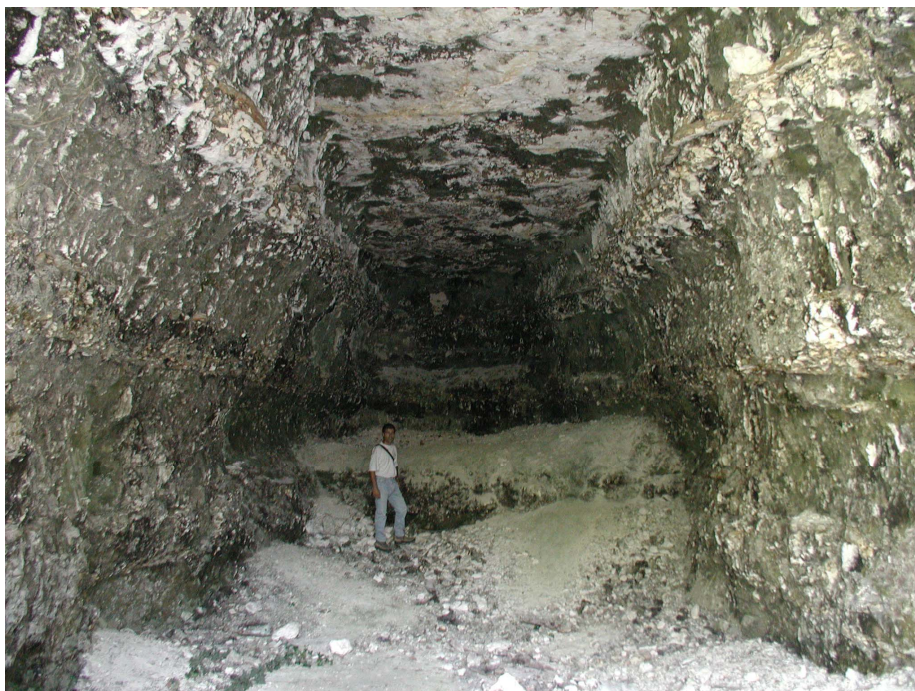
Illustration 15 - Entrée d'une carrière souterraine, dont seul les 20 premiers mètres de galeries sont visibles suite à des effondrements (Bréchamps).
