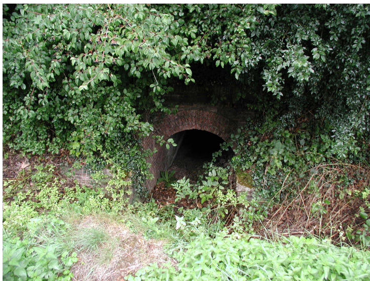
Illustration 25 - Caniveau d'eaux pluviales, Vert-en-Drouais.
