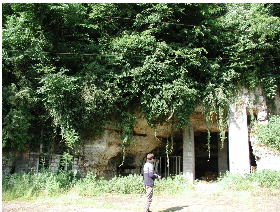
Illustration 14 - Habitation troglodytique confortée à Marboué.
