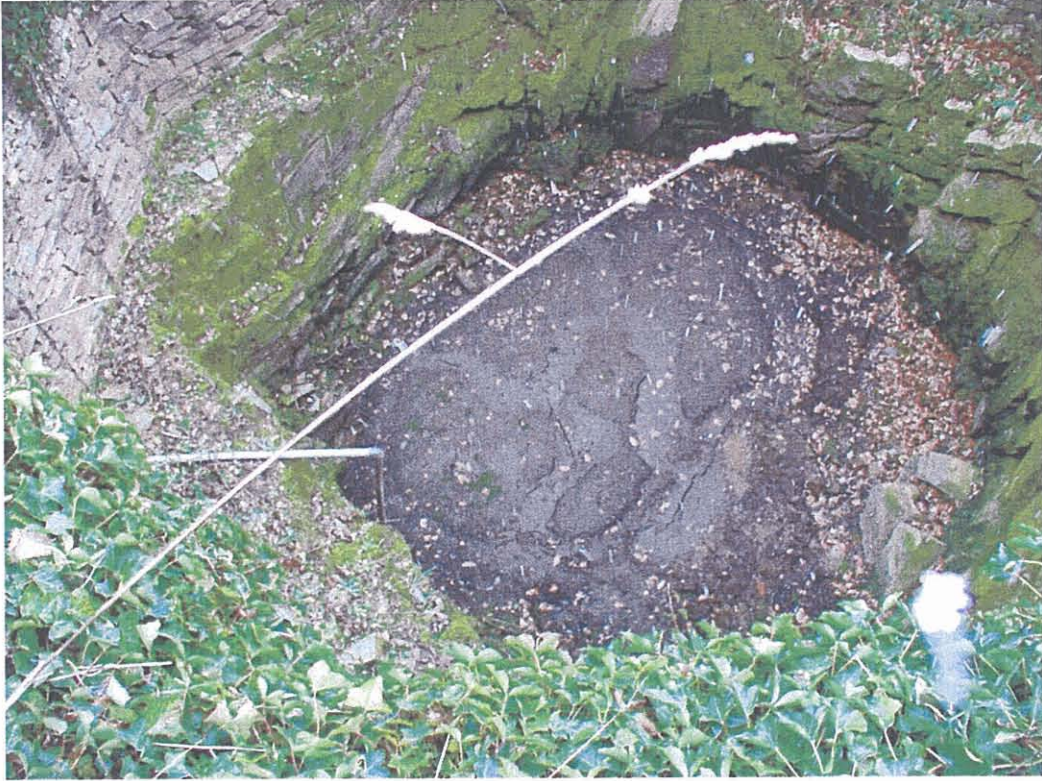
Puits maçonné à sec avec un sous-sol argileux
