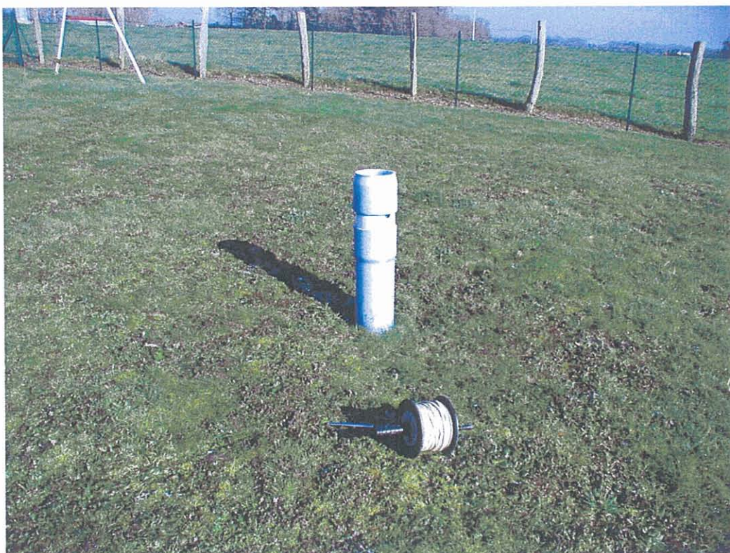
Un piézomètre accessible car pas encore rebouché
