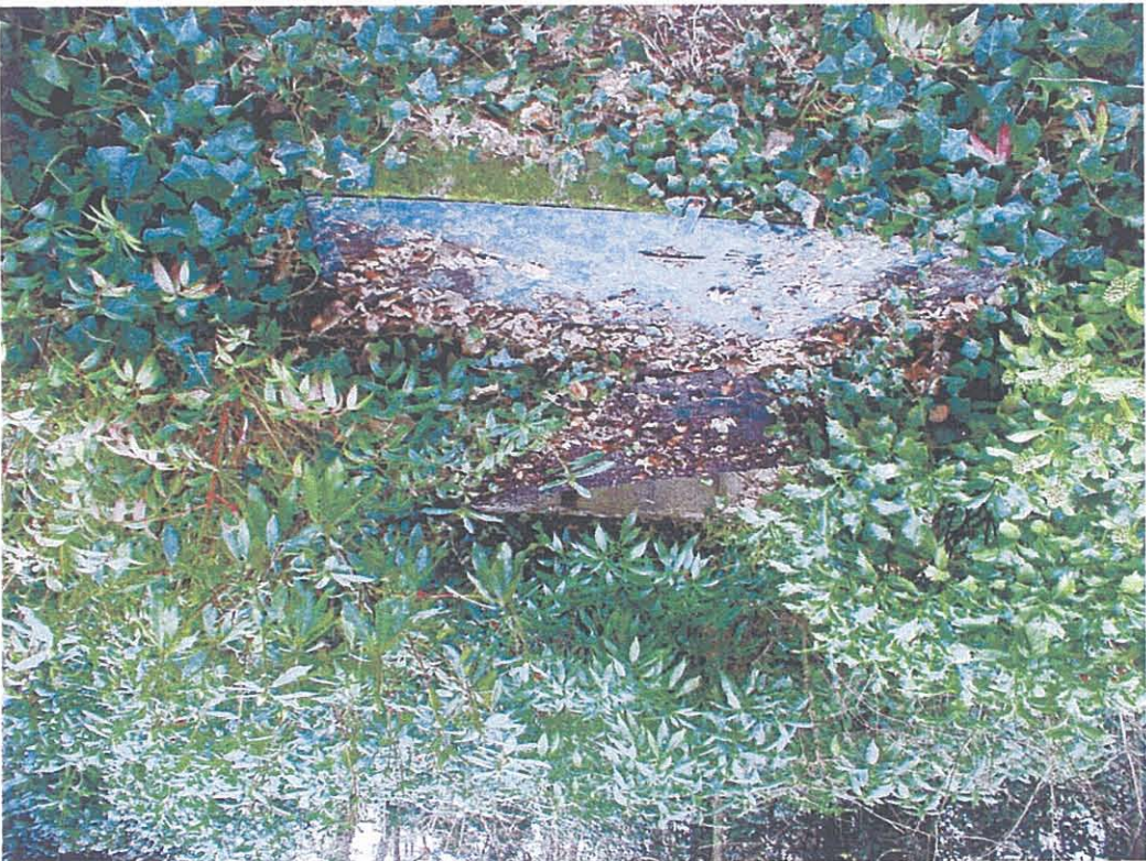
Forage recouvert par une plaque cadernassé
