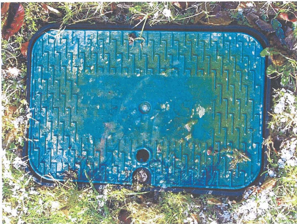
Couvercle vert vissé du forage d'un particulier
