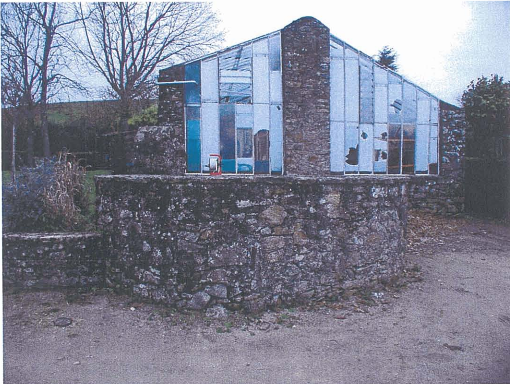
Puits en gros diamètre à proximité de serres municipales
