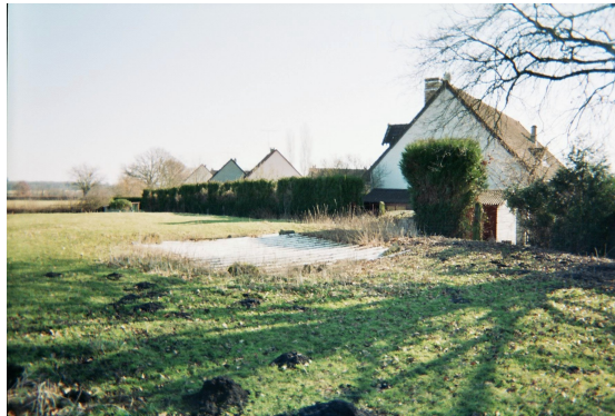
Illustration 15 - Puits de mine effondré protégé par une tôle à Villefranche d'Allier
