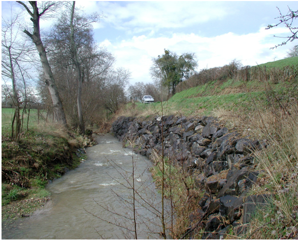
Illustration 9 : Confortement des berges du Graveron (commune de Vaumas)
