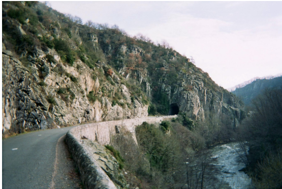
Illustration 12 - RD 109 - Gorges de la Sioule - Tunnel de Chouvigny
