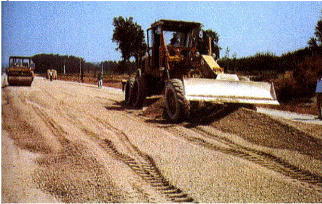
Figure 7 : mise en œuvre de grave-laitier en chaussée neuve. Dans le Tarn-et-Garonne : Rocade de MONTAUBAN
