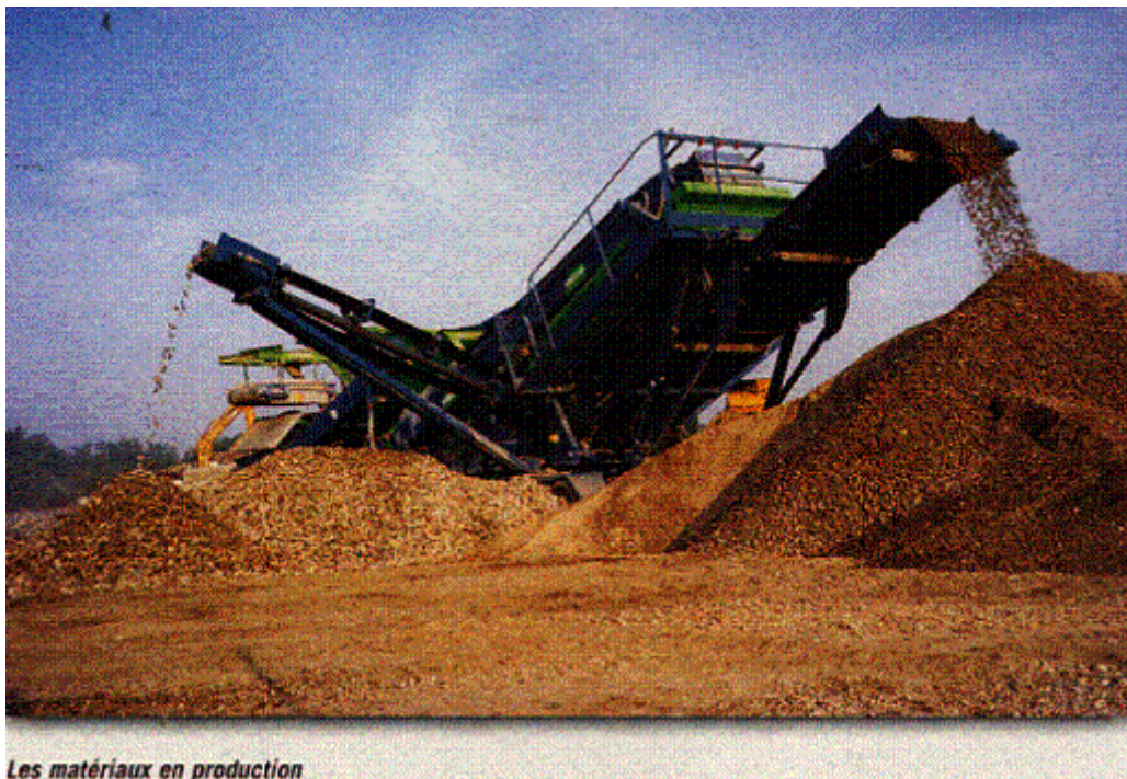
Figure 1 : Matériaux en production (source :Yprema).
