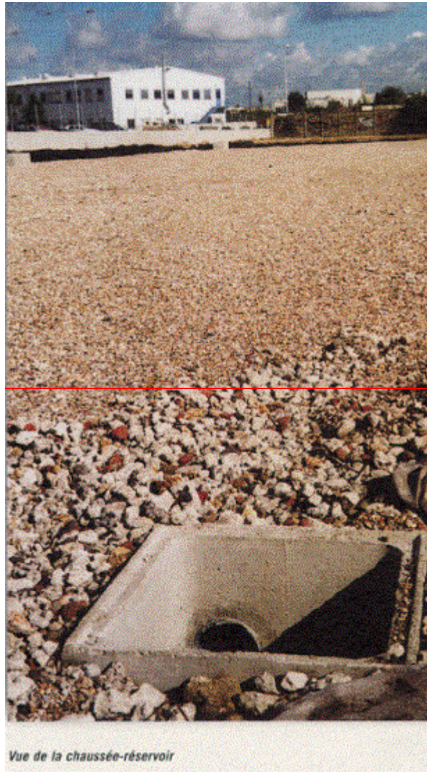
Figure 2 : Exemple de réalisation d'une chaussée réservoir.
