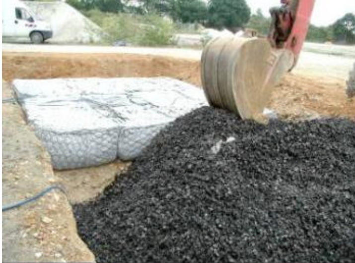
Figure 12 Utilisation en gabion et en vrac des granulats de pneus sous forme de pastille (CER – LMS, 2003 ; Luong et al, 2003)
