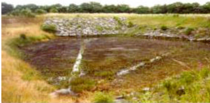
Figure 2 : Bassin d'infiltration des eaux pluviales de Ronchin (Lille)
