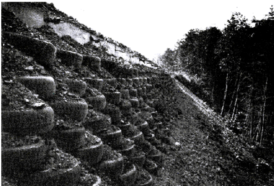
Figure 8 - Vue d'un remblai PNEUSOL â (Beaumont et al, 1987)
