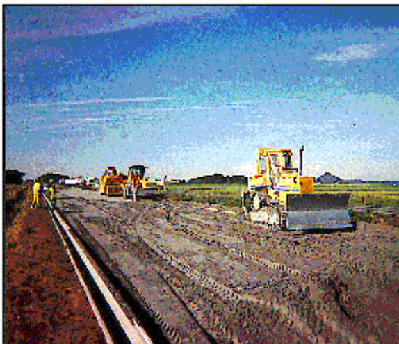
Figure 5 : mise Mise en œuvre de Cendre-Volante-Chaux-Gypse
