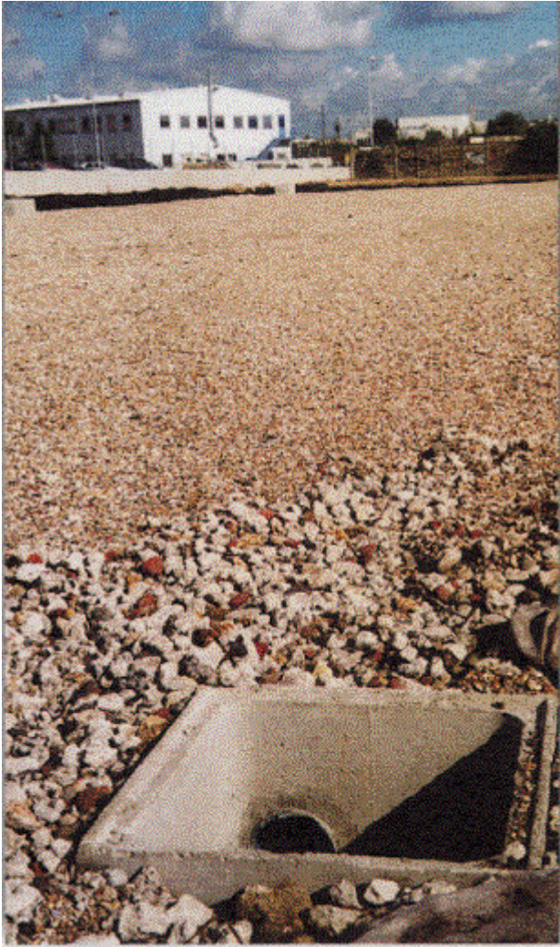
Vue de la chaussée-réservoir
