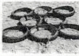
Figure 6 Vue des dispositions des éléments du pneu dans le remblai : Bande de roulement (a) et flancs (b) (Cartier et al, 1981)
