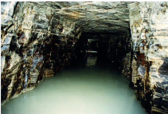
III. 9 - Galerie ennoyée – maison des communes - Espaly
