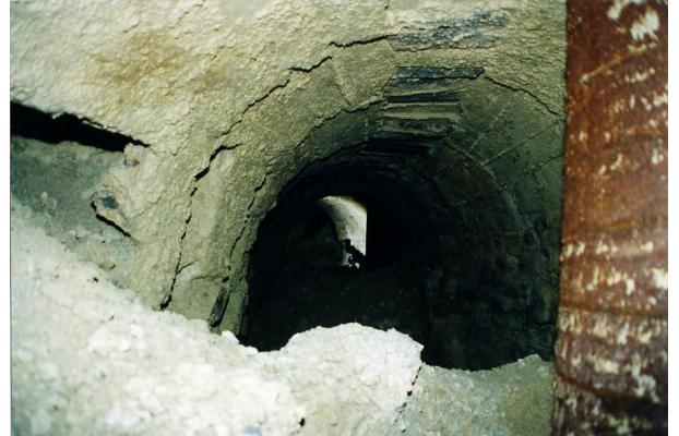
III. 8 - Pieu chemisé dans une galerie à Espaly
