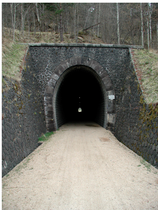
III. 15 - Tunnel de Veneyres (ancienne voie SNCF le Puy-Langogne)
