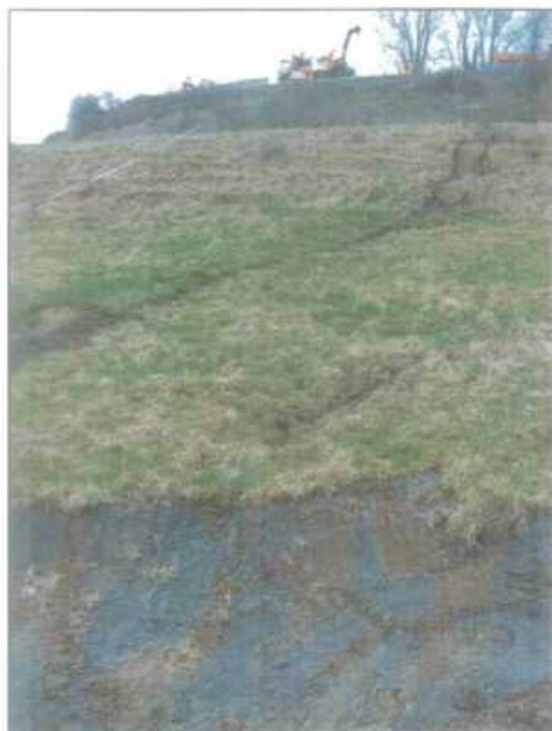
Photo 4 - Vue de la tranchée, vers le haut de la pente.
