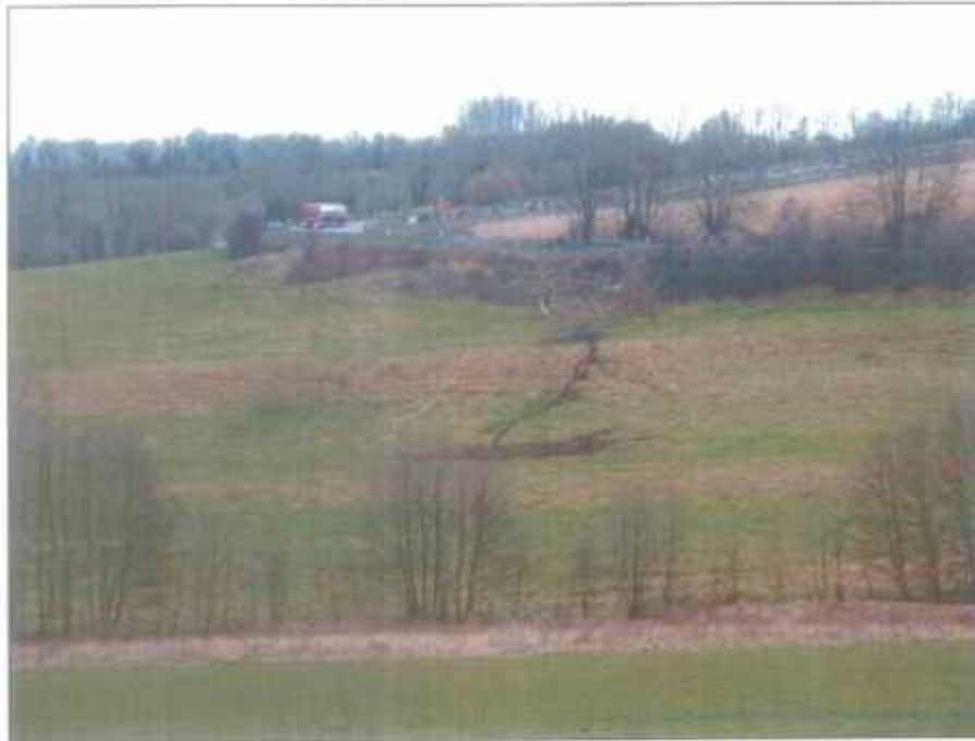
Photo 1 – Vue générale du lieu de l'accident et de la tranchée creusée afin de collecter les hydrocarbures.
