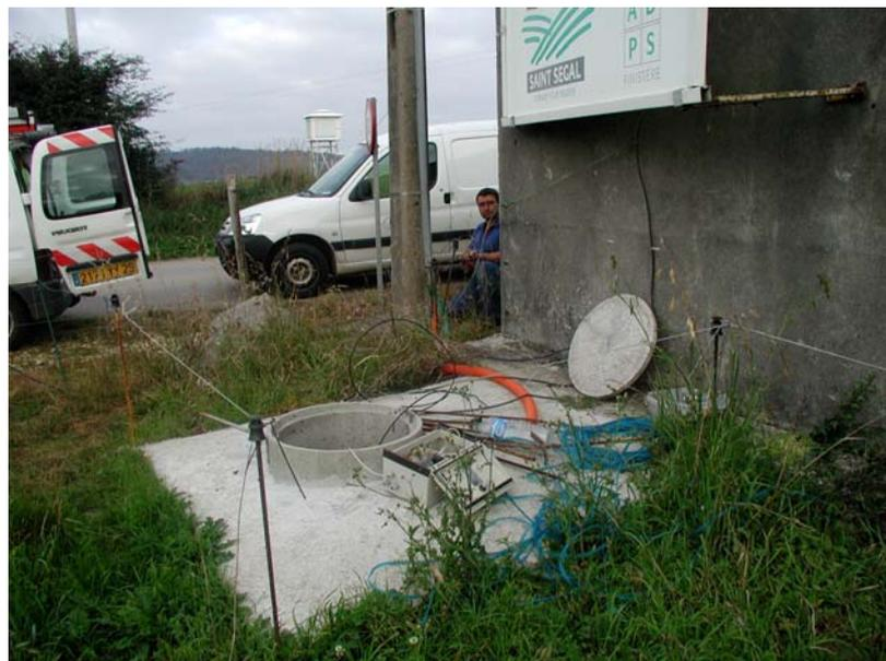
*Figure 20 - Mise en place d'une ligne téléphonique sur le site de Saint-Ségal*
