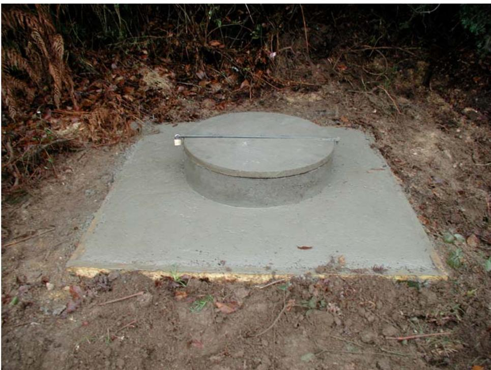
*Figure 8 - Photographie de l'aspect extérieur du forage après aménagement (site de Ploërdut)*
