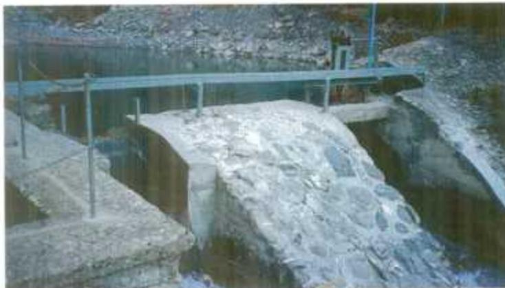
*Photo 2 – Barrage et prise d'eau amont*
