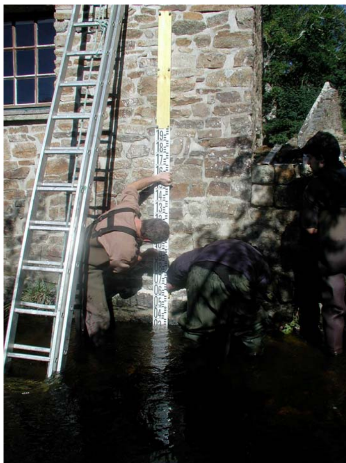
Mise en place de l'échelle limnimétrique à Moulin Nézet (Belon)
